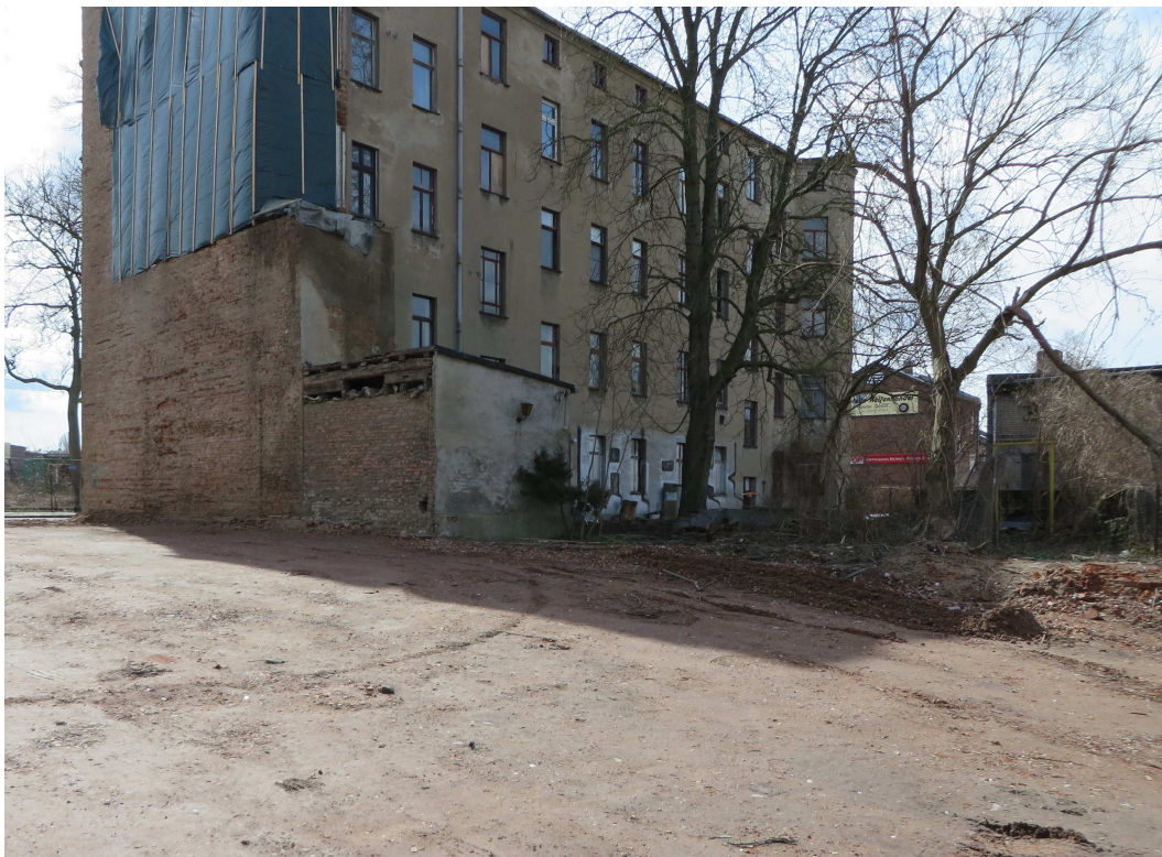
Abb. 6: Typisches zum Abriss vorgesehenes Gebäude im Osten des UG
