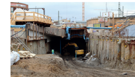
Beginn des Tunnelaushubs am Damaschkeplatz (Bauphase 4)
