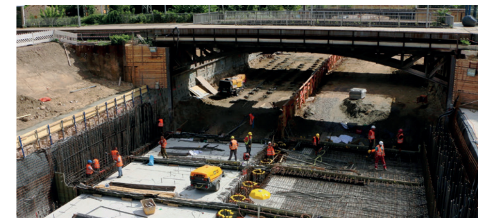
Herstellung der Tunneldecke
