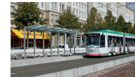
Bau der Ersatzhaltestelle Weinarade/City Carré (Bauphase 2)
