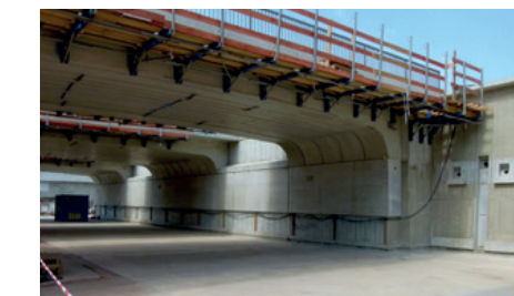
Einbau der neuen Bahnbrücken (Bauphase 3)
