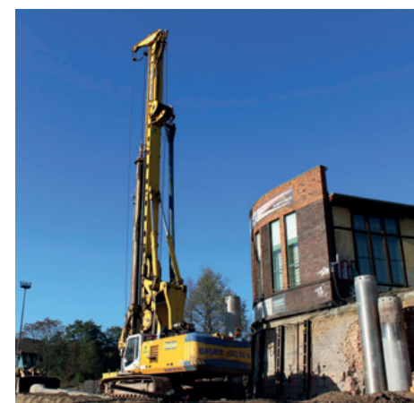
Bohrgerät zur Bohrpfahlherstellung
