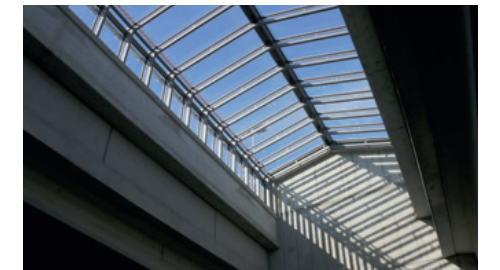
Glasdach zwischen den neuen Brücken
