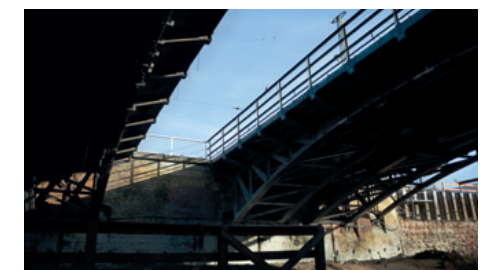
Alte Bogenbrücken, stahleres Fachwerk
