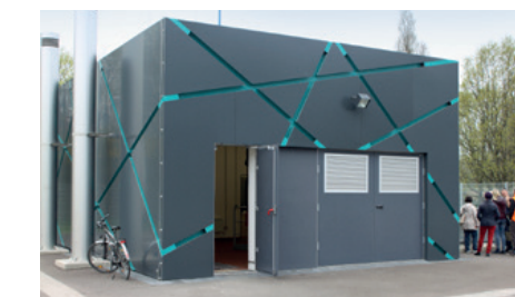
Betriebsgebäude der AGM am Damaschkeplatz (Bauphase 1)
