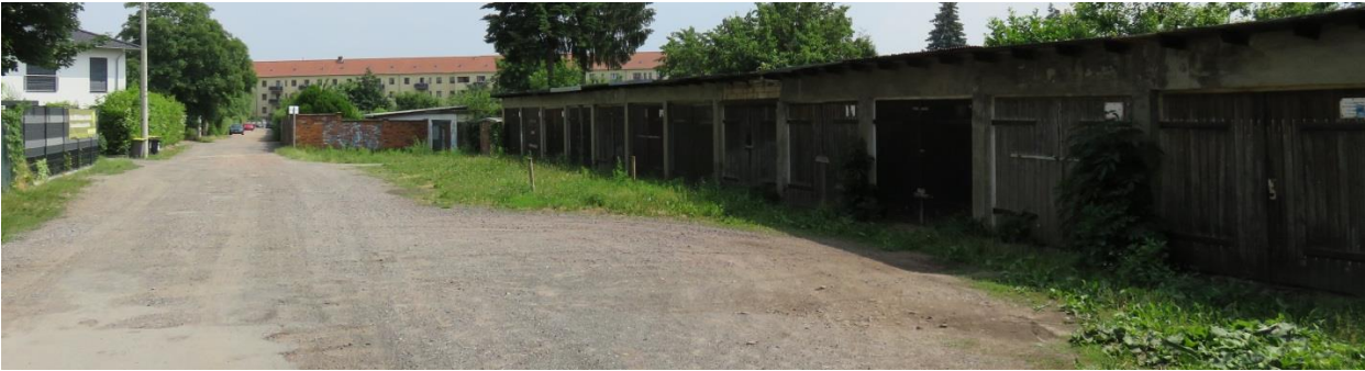
Abbildung 2: Garagenkomplex mit vorgelagerter z. T. überwachsener Schotterfläche
