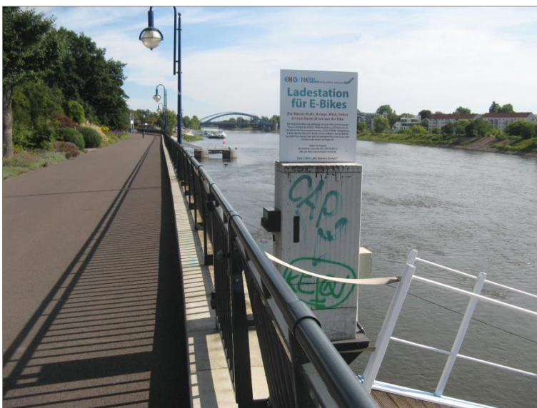
Foto 07 – Ladestation E-Bike (Bild IBB GmbH)
