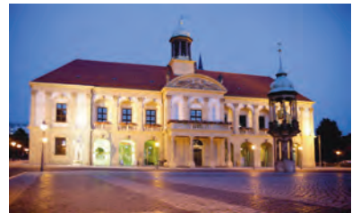
Das Magdeburger Rathaus entstand im Zuge der Ausbaurbeiten der einstigen Lager-/Kaufhalle der Kürschnerinnung. Von diesem Bauwerk hat nur der Ratskeller die Zerstörungen überstanden, in dem sich heute ein Restaurant befindet.
