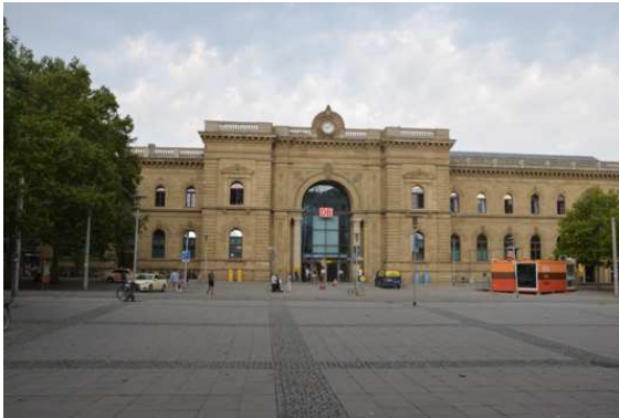
Abb. 34: Gestaltungsdefizite am Bahnhofsvorplatz (© Urban Catalyst)
