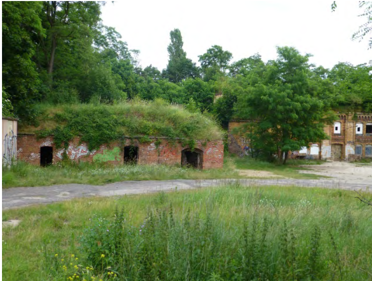
Ansicht Kavalier über den Innenhof (v.l.n.r.)
