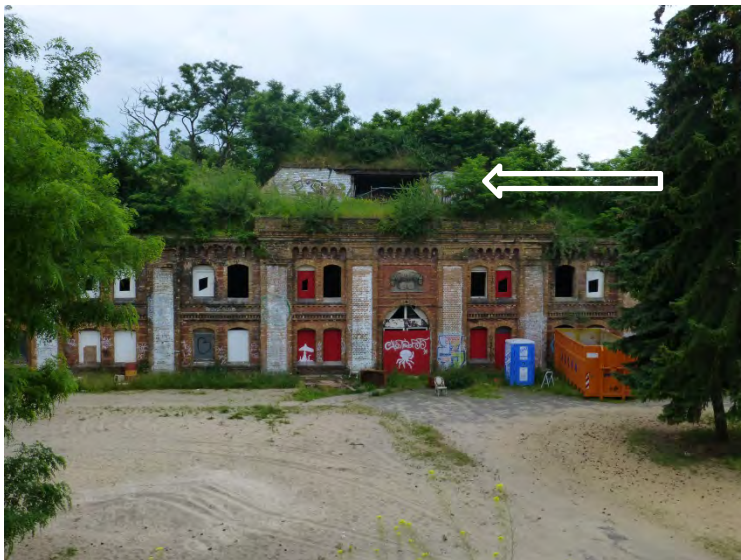
Mittelteil mit Schachtöffnung (Pfeil) über der oberen Abdeckung
