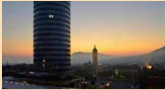
↑ Abb.17. Hochhaus und Stadtkirchenturm in Jena, Thüringen, in Kontrast zu den umgebenden Karsthängen gesetzt
