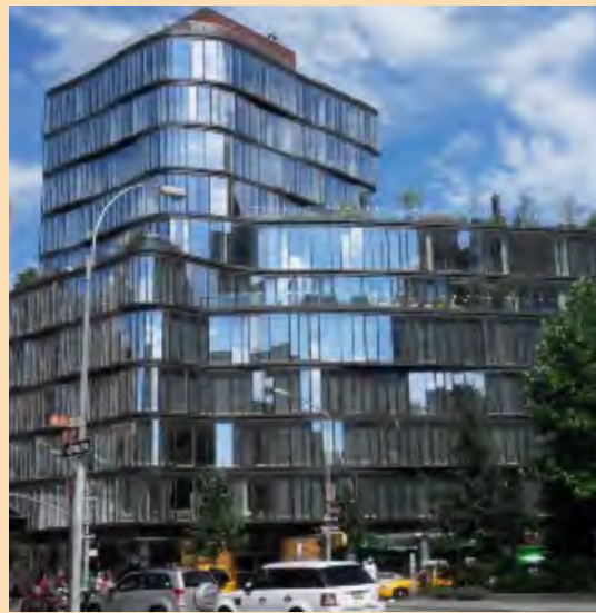
↑ Abb.43. One Jacksons Square, New York. William Pedersen, Kohn Pedersen Fox Architects 2009. Einem geschlossenen Sockel, der die Höhen der umgebenden „Brownstones“, also der historischen Blockrandbebauung, aufnimmt, sitzt ein volumenbetont durchgeformter Eckturm auf.
