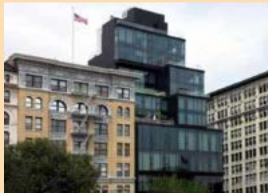
↑ Abb.27. 15 Union Square West, New York von Eran Chen, ODA-Architecture. Nachdem die ursprünglich sechsgeschossige Fassade mit gusseisernen Stützen rekonstruiert und um sechs weitere Geschosse aufgestockt wurde, beherbergt dieses Hochhaus nun attraktives „High End“-Wohnen
