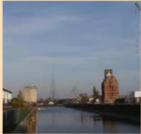
↑ Abb.61. Speicher im Wissenschaftshafen – Teilabriss für den Umbau zu Wohnungen
