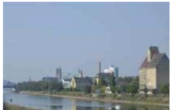
↑ Abb.97. Ansicht Magdeburgs von Bahnelbenbrücke
