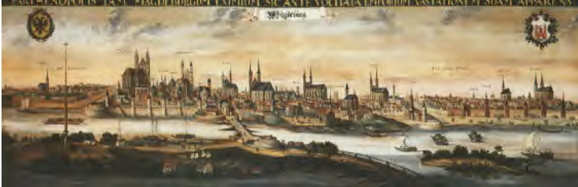
↑ Abb.83. Ansicht Magdeburgs mit sieben Doppeltürmen vor der Zerstörung 1631.
