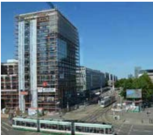
↑ Abb.90. Hochhausneubau am Ort des ehemaligen Blauen Bocks. Es ist der zentrale Verkehrsknotenpunkt der Innenstadt neu betont und gefasst worden. Foto vom Bauzustand.
