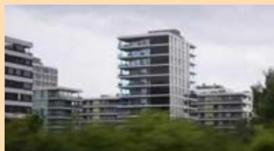
↑ Abb.28. Feldpark, Wiederkehr Krummenacher Architekten AG, Zug, Schweiz. Durch Vertikalakzente angereicherte Vorortsiedlung bei Zürich
