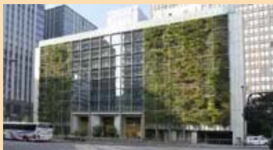
↑ Abb.33. Begrünte Hochhausfassade in Tokyo. Intensive, durch den hohen Wasserbedarf aufwändige Fassadenbegrünungen tragen zur aktiven Temperaturreduktion in überwärmten Stadtteilen bei.
