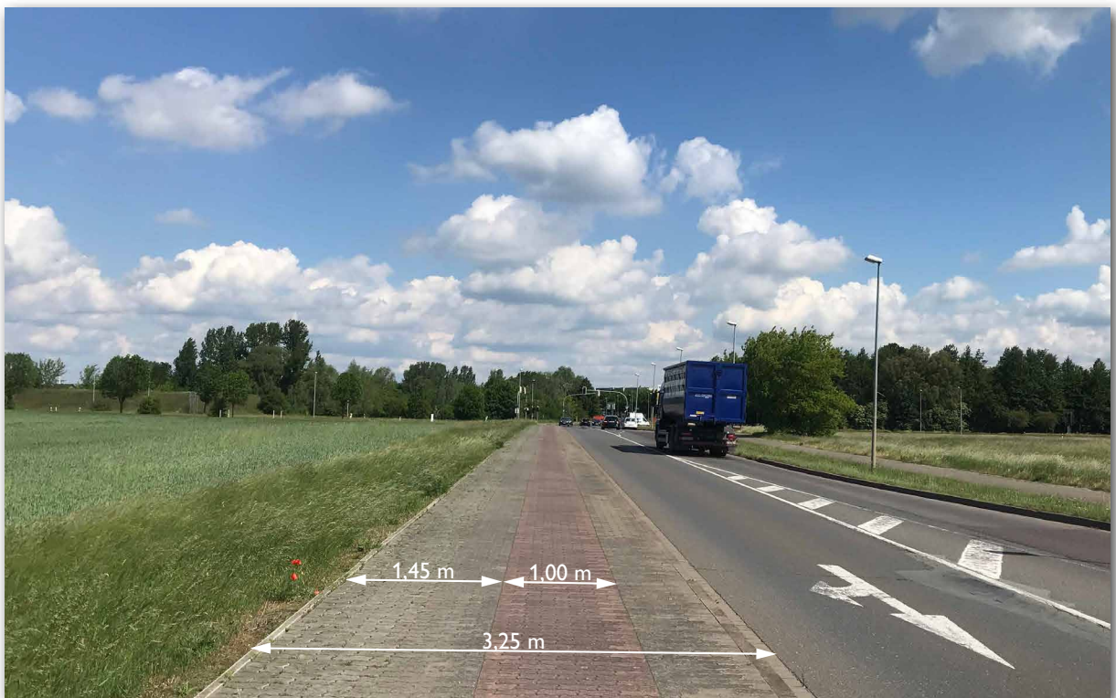
Abbildung A-6 getrennter Geh-/Radweg, Kümmelsberg Westseite – Blickrichtung N
