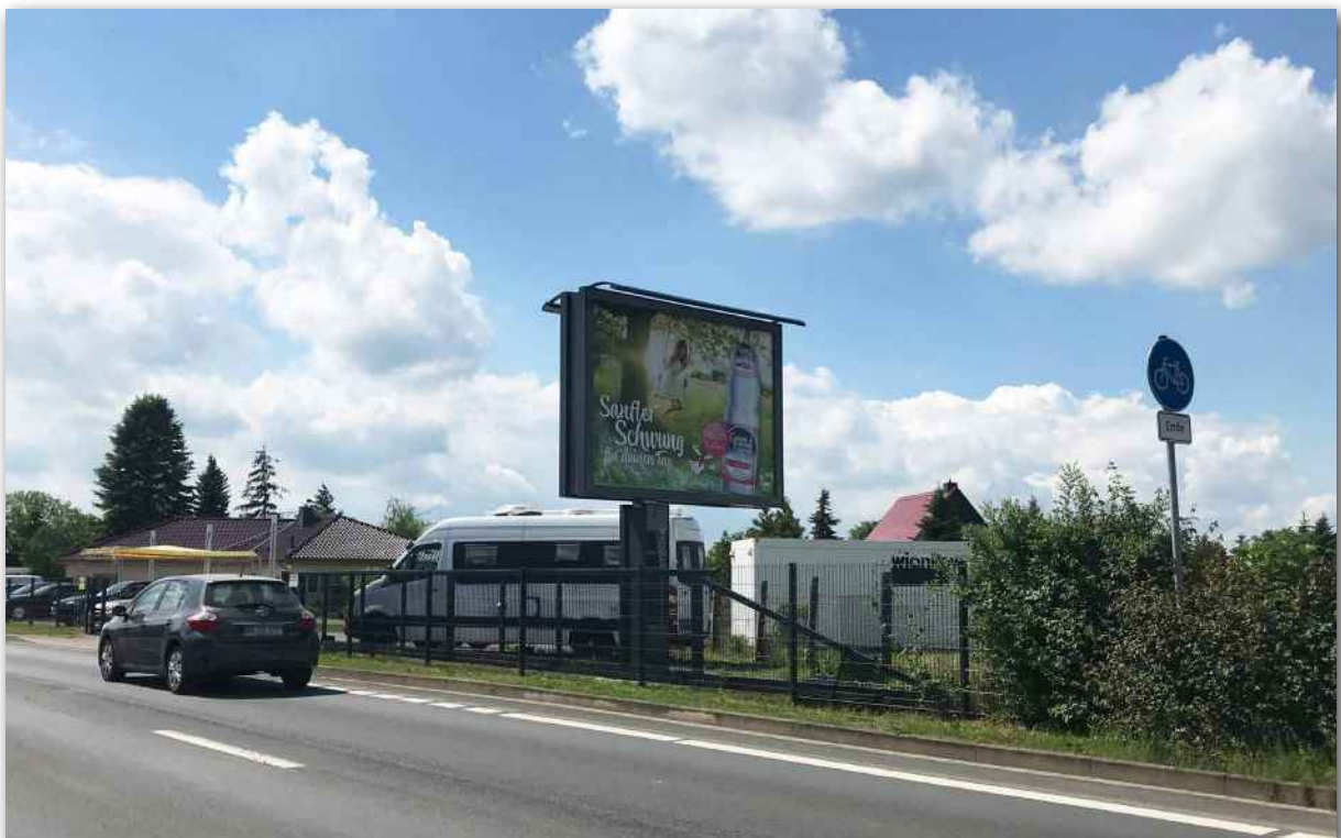
Abbildung 9 Radweg-Ende, Kümmelsberg Westseite – Blickrichtung SW
