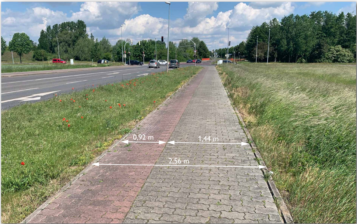
Abbildung A-7 getrennter Geh-/Radweg, Kümmelsberg Ostseite – Blickrichtung S
