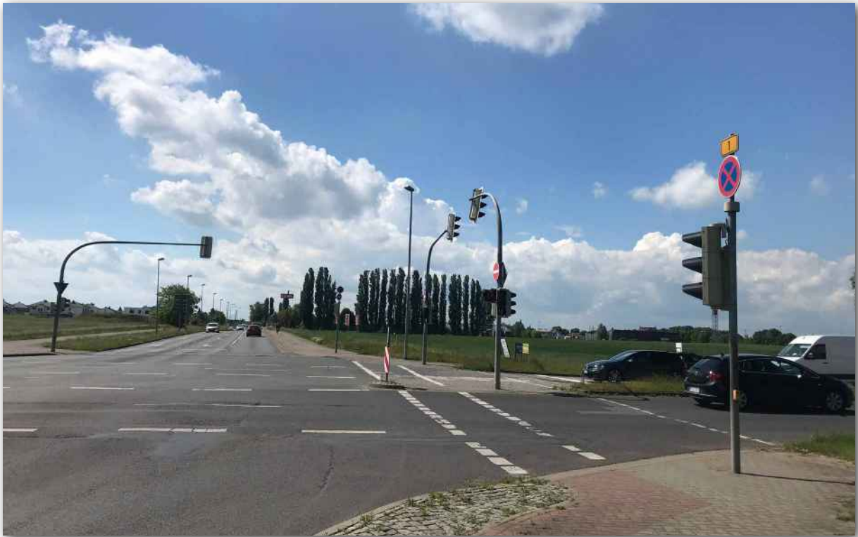
Abbildung A-28 KP 1 | Zufahrten Süd und West des – Blickrichtung S
