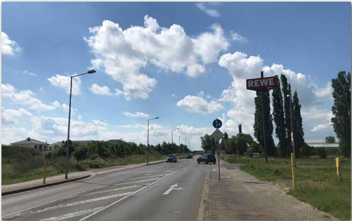
Abbildung A-32 KP2 | Situation am Knotenpunkt – Blickrichtung S
