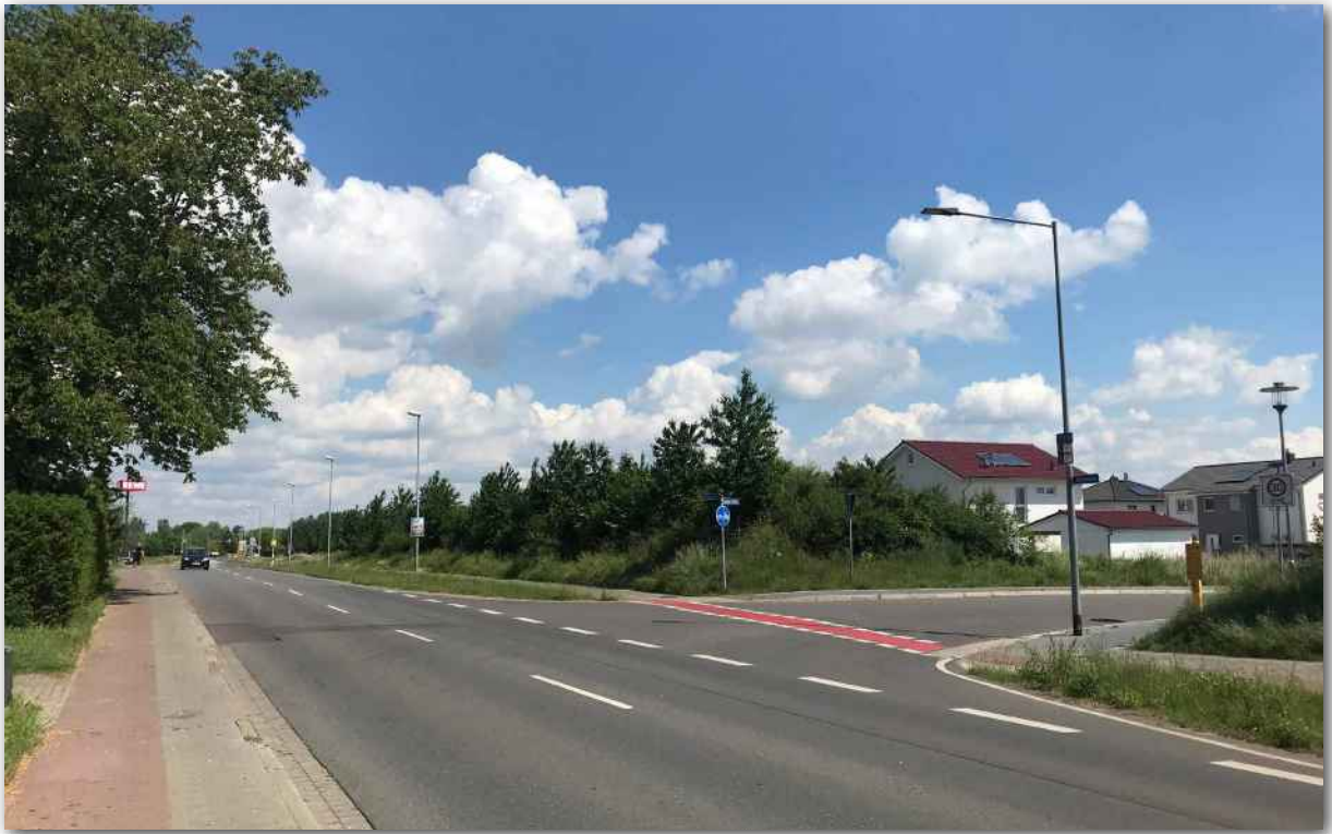
Abbildung A-34 KP3 | Situation am Knotenpunkt – Blickrichtung NO
