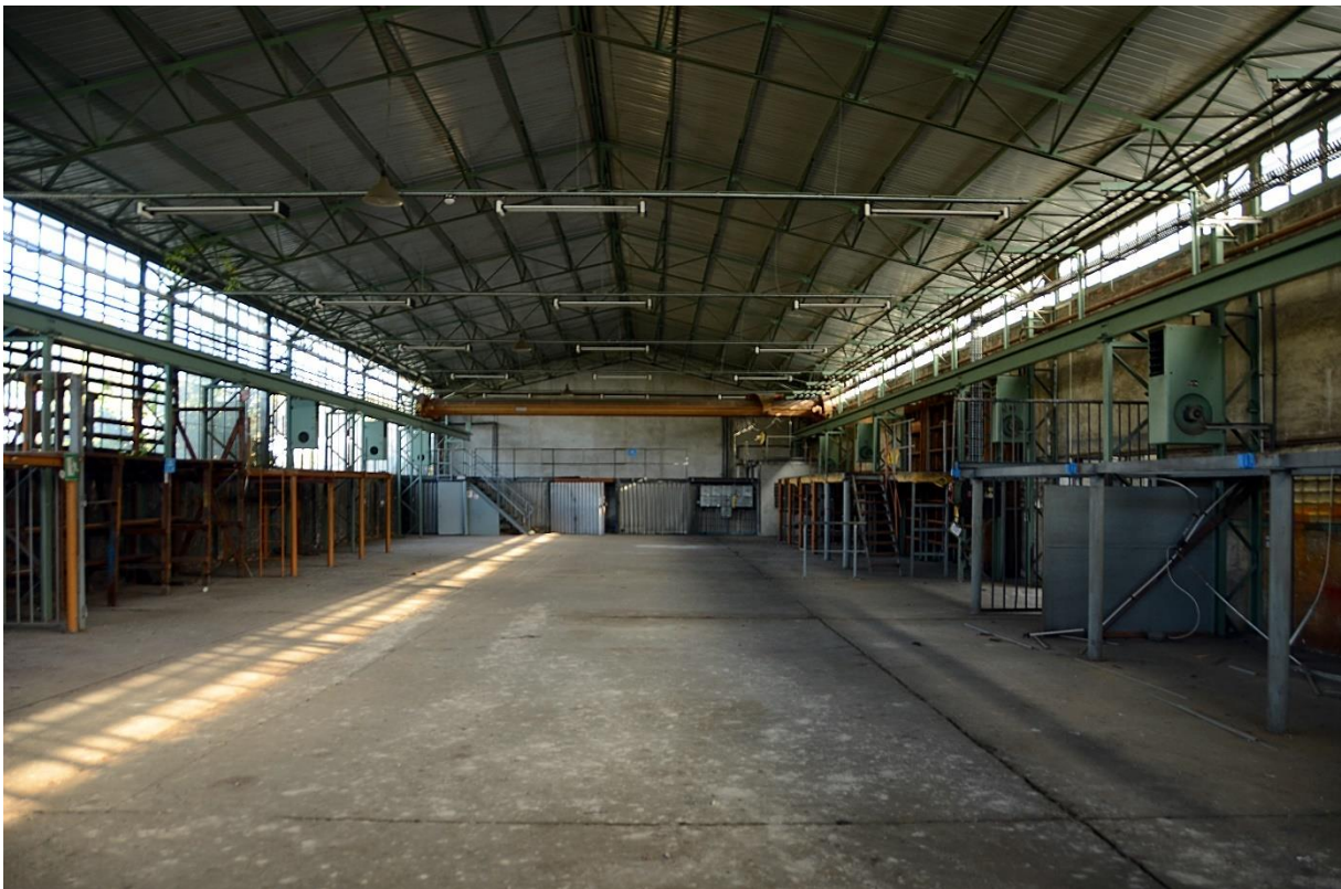
Abbildung 3 Die Werkhalle des Gebäude 4
