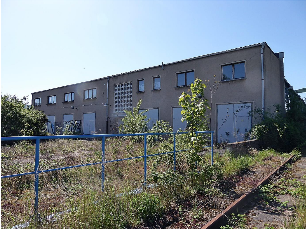
Abbildung 4 Gebäude 4, Nordseite mit dem Bürokomplex und den Garagen (Aufnahme vom Mai 2022)
