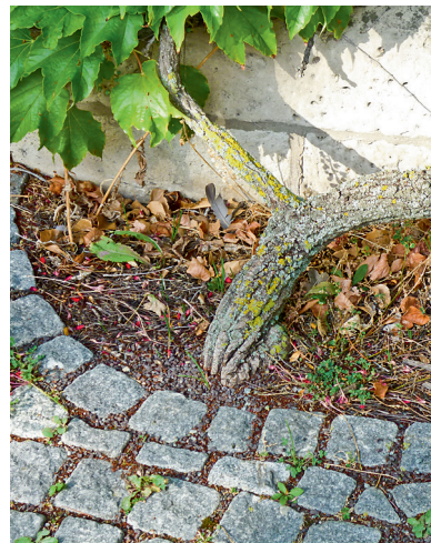
Die Einfassung der Pflanzfläche schützt das umgebende Pflaster vor Lockerung und Zerfall.
