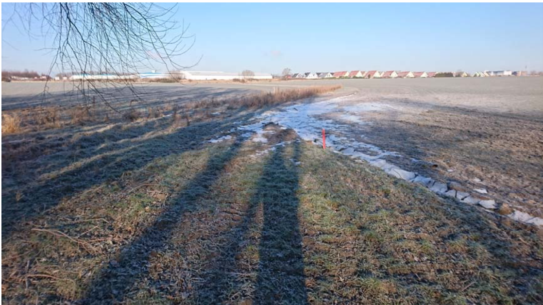
Bild – Ansicht des Beckenbereiches von Südosten (weiß – gefrorenes Stauwasser; heller Pflock im Hintergrund = BS 10 Bohrstelle)
