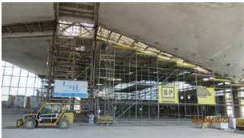
Sanierung der Hyparschale
