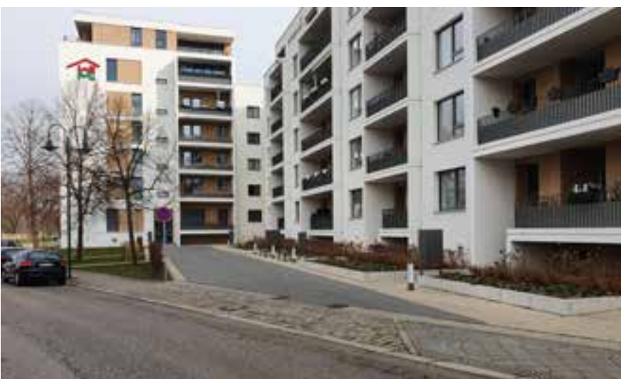
Sanierter Plattenbau in der Turmschanzenstraße
