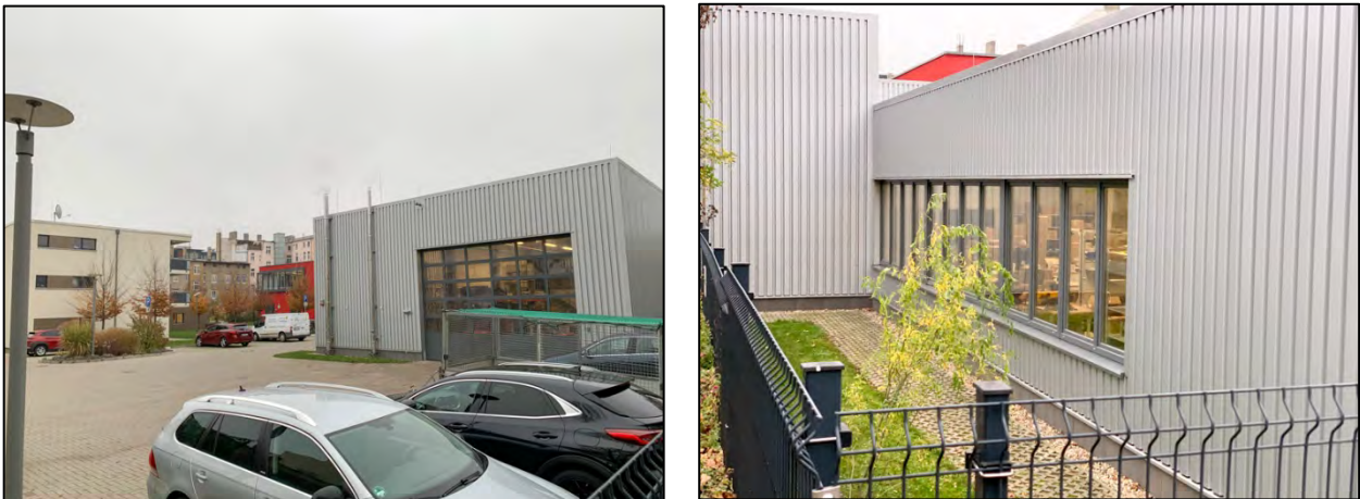
Bild 3: Betriebsgelände der Lebenshilfe Magdeburg
