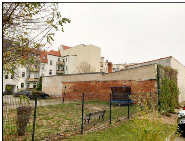
Bild 2: Blick auf den Autoservice Andreas Rusche von der Ackerstraße aus
