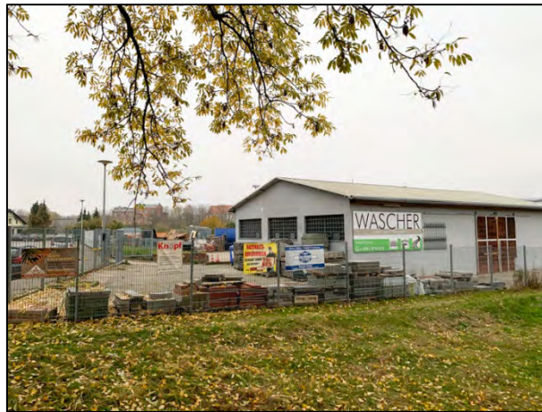
Bild 5: Betriebsgelände des Wascher Zaunbau, Carports & Pflasterarbeiten
