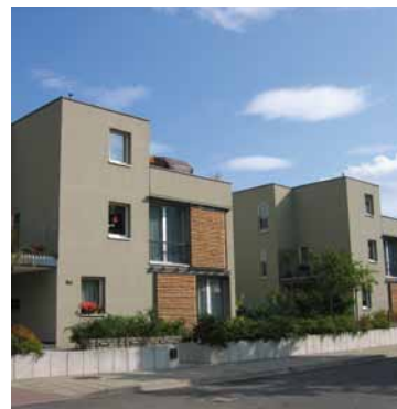
Neubau von Stadtvillen aus gebrauchten Betonelemente am Standort Cottbus
