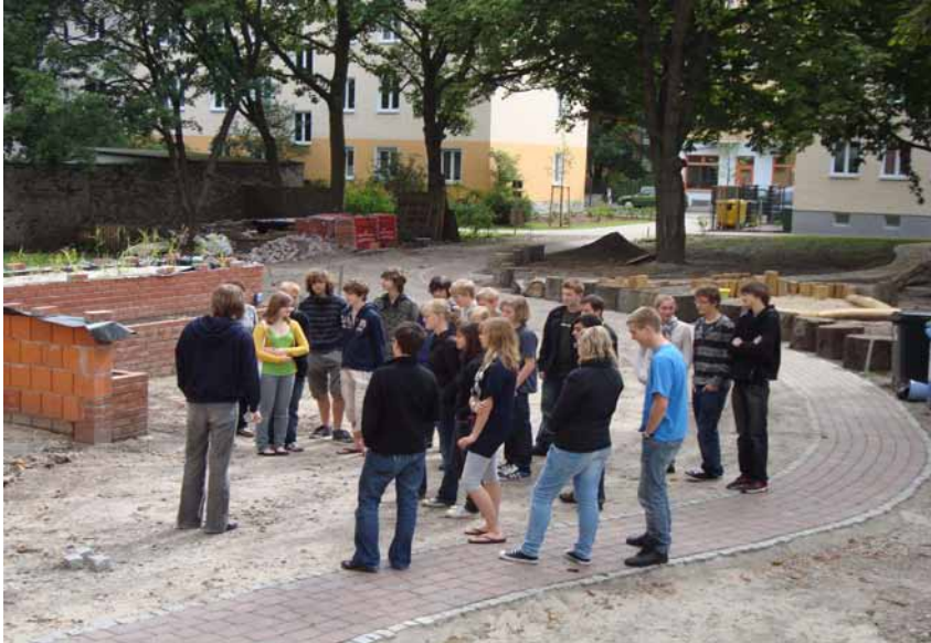
Auch Öffentlichkeitsarbeit gehört zum Projekt: Schüler besichtigen die noch im Bau befindlichen Pflanzenfilteranlagen.
