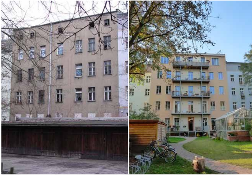
Die Ostansicht des Berliner Altbaus vor und nach der Sanierung
