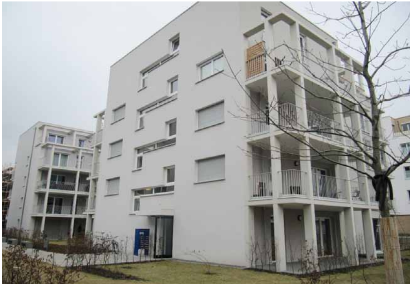
Die Wohnungsbaugesellschaft GAG hat im Zuge der Rheinuferbebauung das abgebildete Gästehaus mit RC-Beton errichtet.
