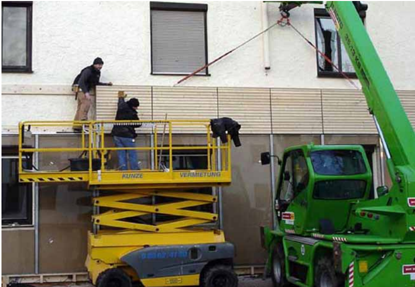
Die energiesparenden Fassadenelemente können von außen leicht montiert werden.
