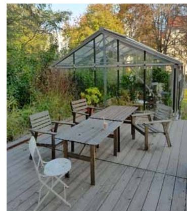
Der Vertikalpflanzenfilter für Regenwasser und das Gewächshaus mit den Fließbeetfiltern bilden einen grünen Hintergrund für die Terrasse.
