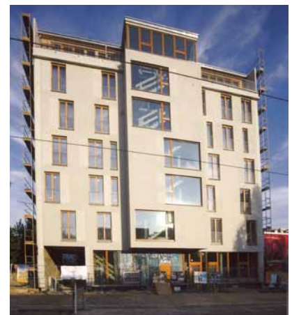
Kombiniert auf innovative Weise bewährte und neue Technologien: der Passivhaus-Neubau der Leuchtturm eG in Berlin
