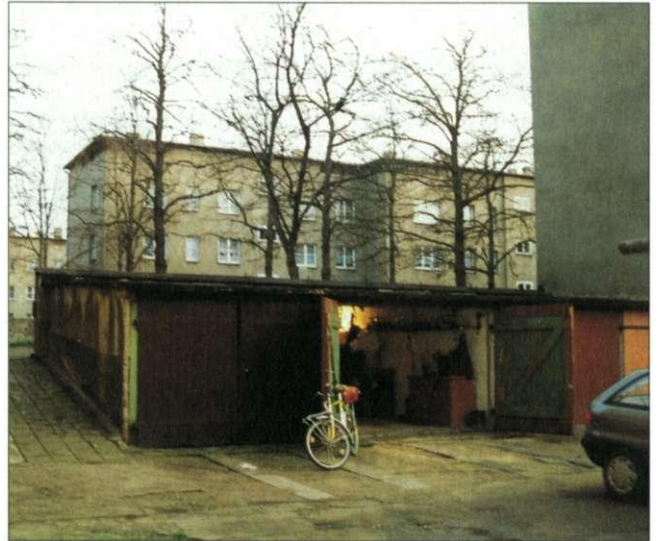
Garagen im Innenhof (Mehringstraße 13)
