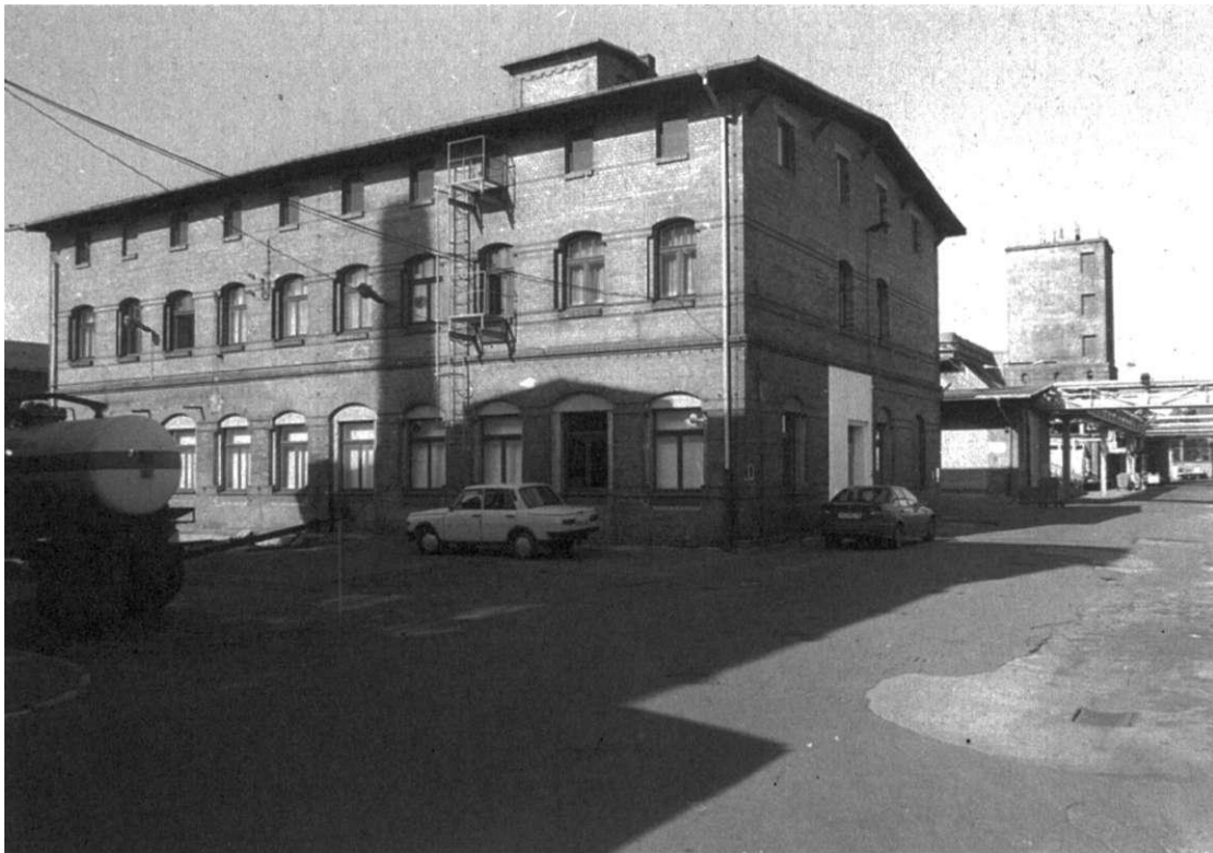
Die Darmschleimerei wurde bei der zweiten Bebauungsphase aufgestockt.
