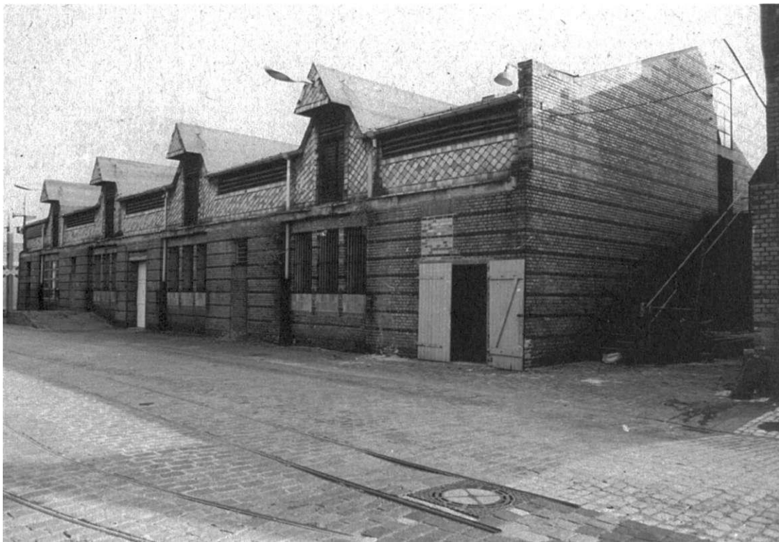
Östlicher Anbau der Schweineställe.
