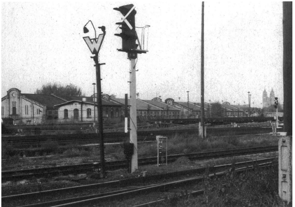
Viehhofställe, von den Bahnanlagen aus gesehen.
