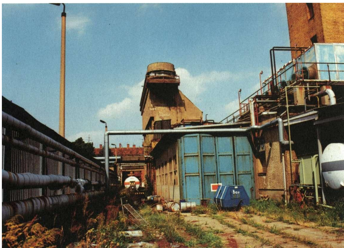
Technik gibt es immer noch am Maschinenhaus.
