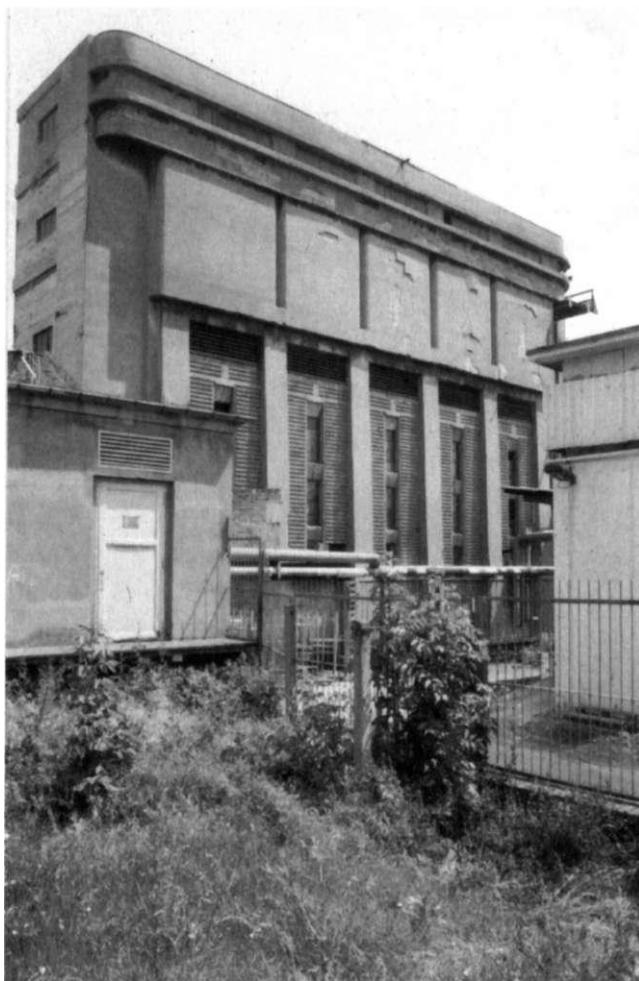
Reizvolle Details sind die Mauerwerkstreifen am Kohlenbunker.
