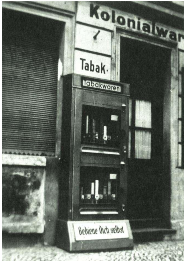
Abb.: Die ersten Zigaretten-Automaten in der Neuen Neustadt, Neuhaudensleber Straße 25
