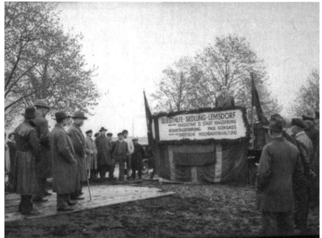
Abb. 32: Erster Spatenstich an der Kreuzbreite
