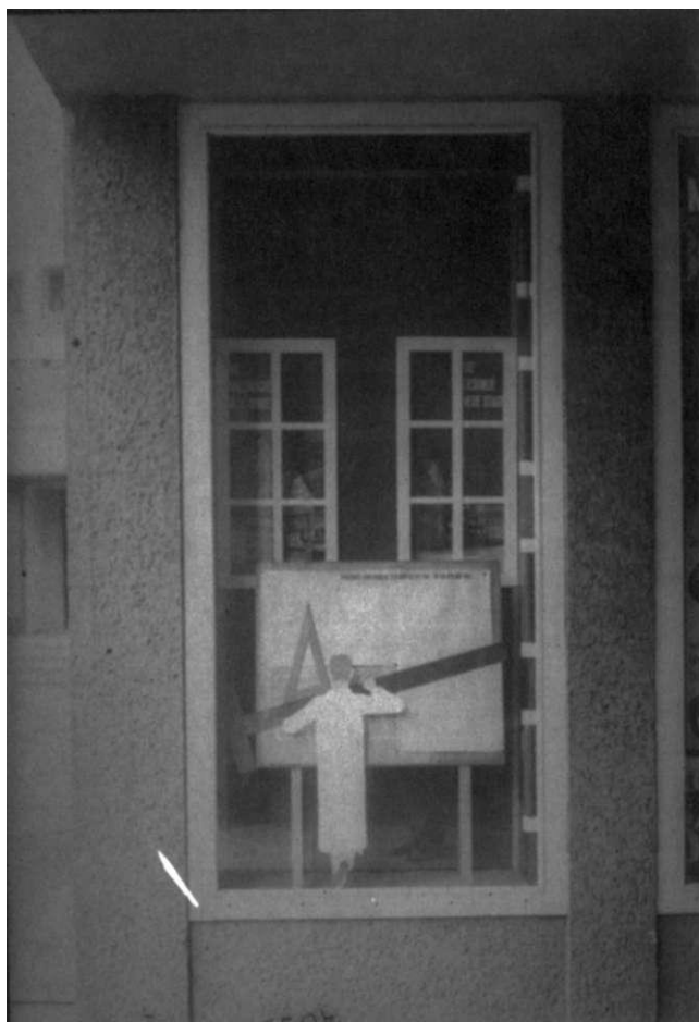
Abb. 3: Vitrine des Hochbauamtes an der Stadthalle, 1930
