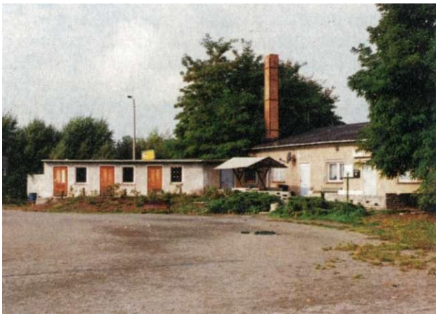
Sozialtrakt des Sportplatzes Büchnerstraße vor Abriss Social facilities at the sports ground Büchnerstraße prior to demolition
