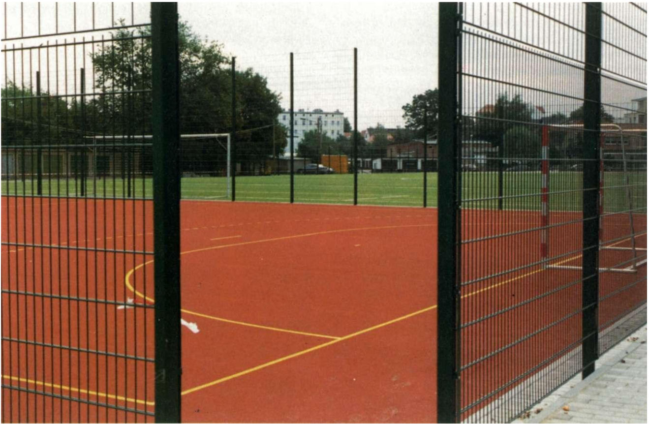
Sportplatz Büchnerstraße nach der Umgestaltung Büchnerstraße sports ground after restoration
