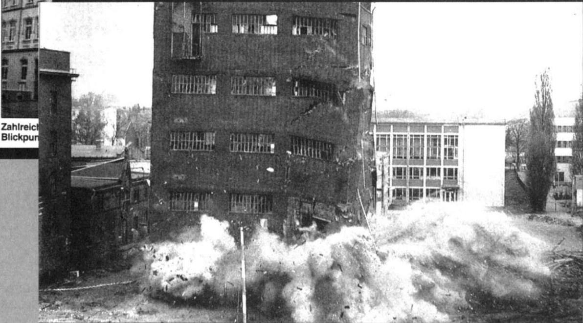
Gegen 11.30 Uhr ließ Sprengmeister Bühring zünden. Das Gebäude hüllte sich in eine riesige Staunwolke und kippte. Fotos (2) Elke Neubert*
