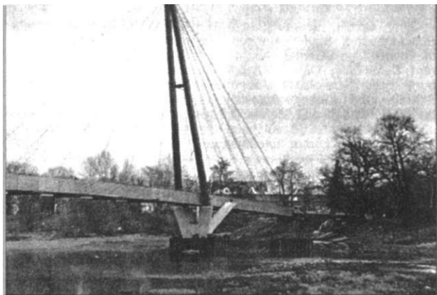
Anfang Dezember wurde die neue Radfahrer- und Fußgängerbrücke übergeben, die den Stadtteil Cracau mit dem Kulturpark Lotehorn verbindet.
