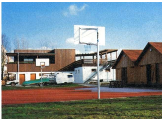
Kanuclub „Falke“ nach der Sanierung Falke canoe club after renovation
