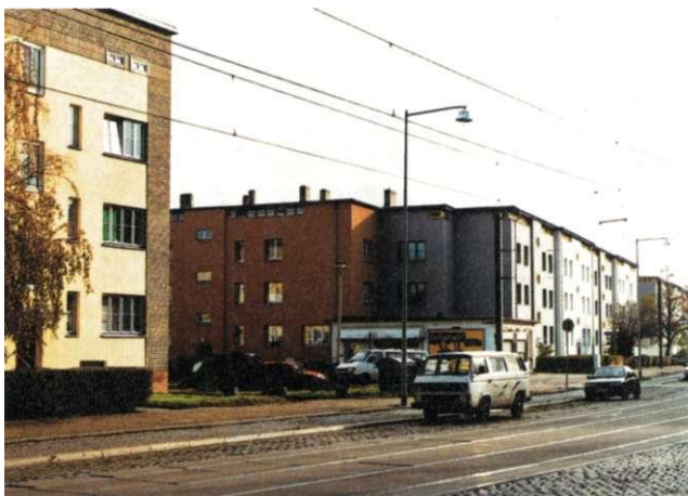
Sanierte Gebäude in der Cracauer Straße Restored buildings in the Cracauer Straße
