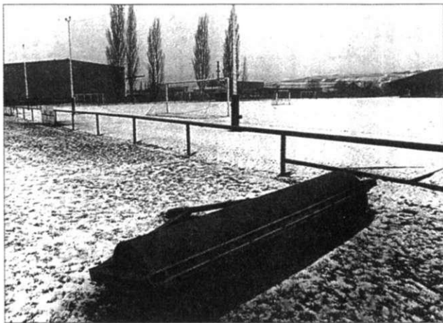
Durch zusätzliches Urban-Geld ist auch die Sanierung des Sportplatzes am Gübser Weg möglich. Fast sieht es so aus, als warte diese Walze schon auf ihren Einsatz. Im Frühjahr sollen die Arbeiten starten.
