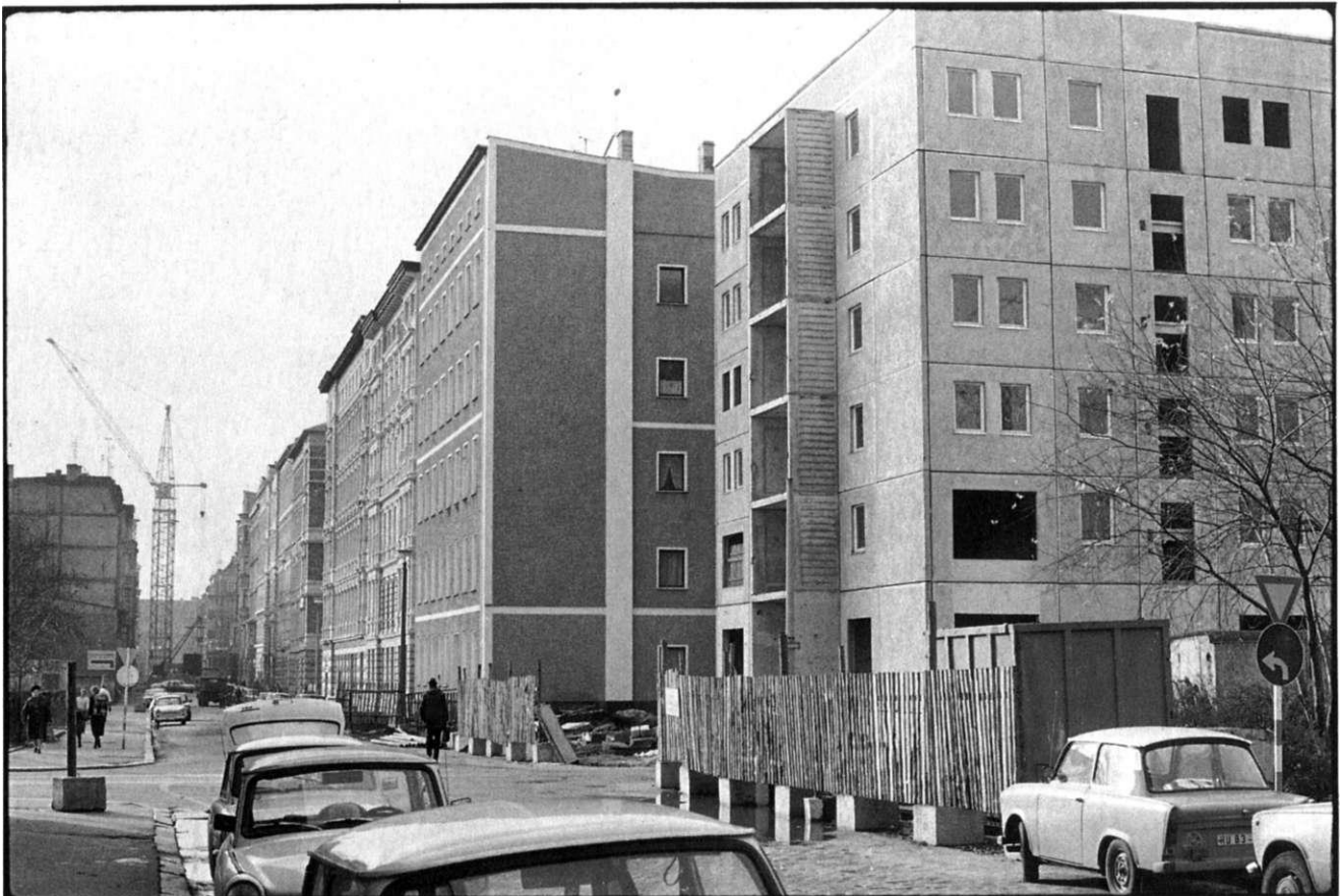
Plattenbau Ecke Keplerstrasse/Leibnizstrasse während des Baus
