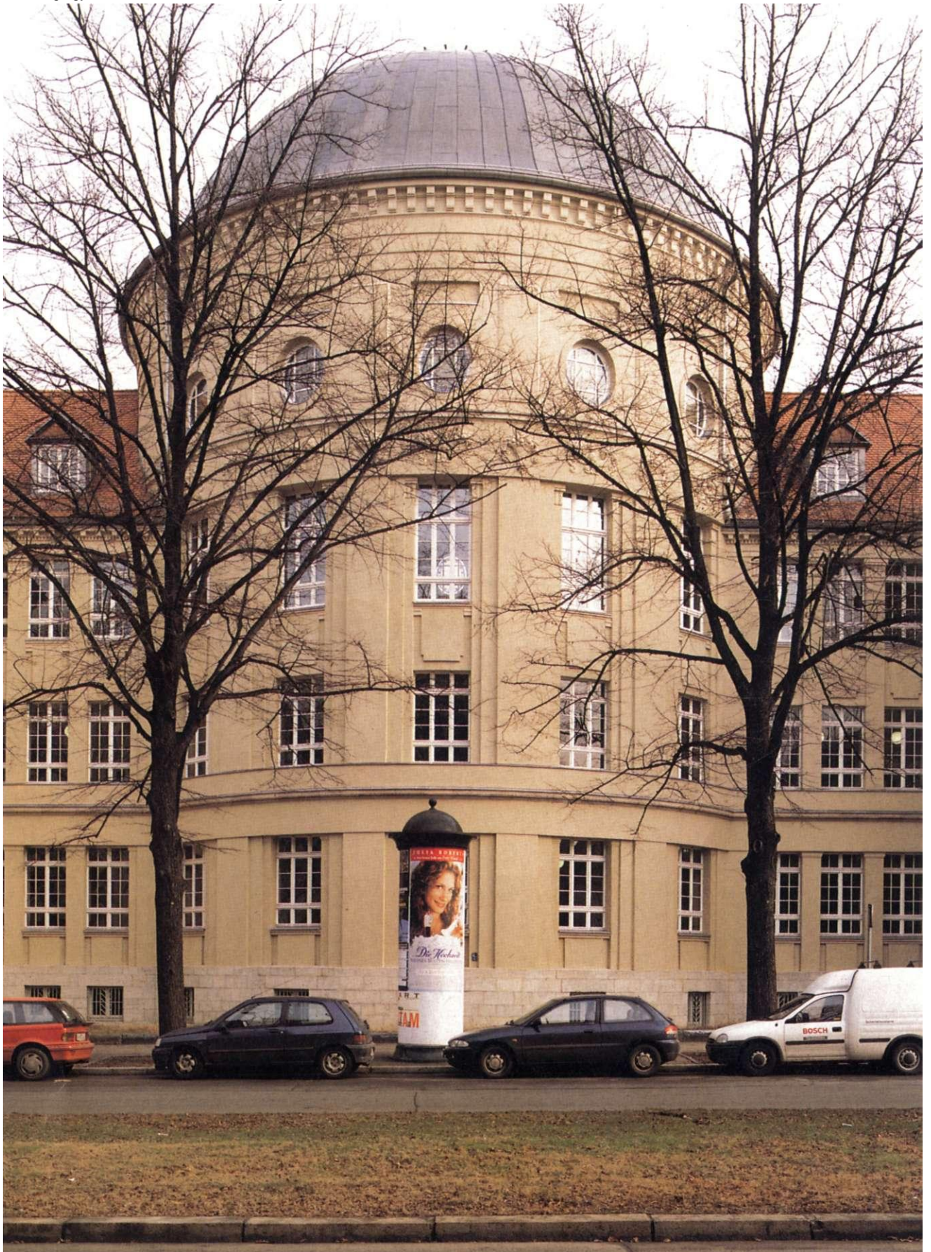
Das Hegelgymnasium nach der Sanierung
