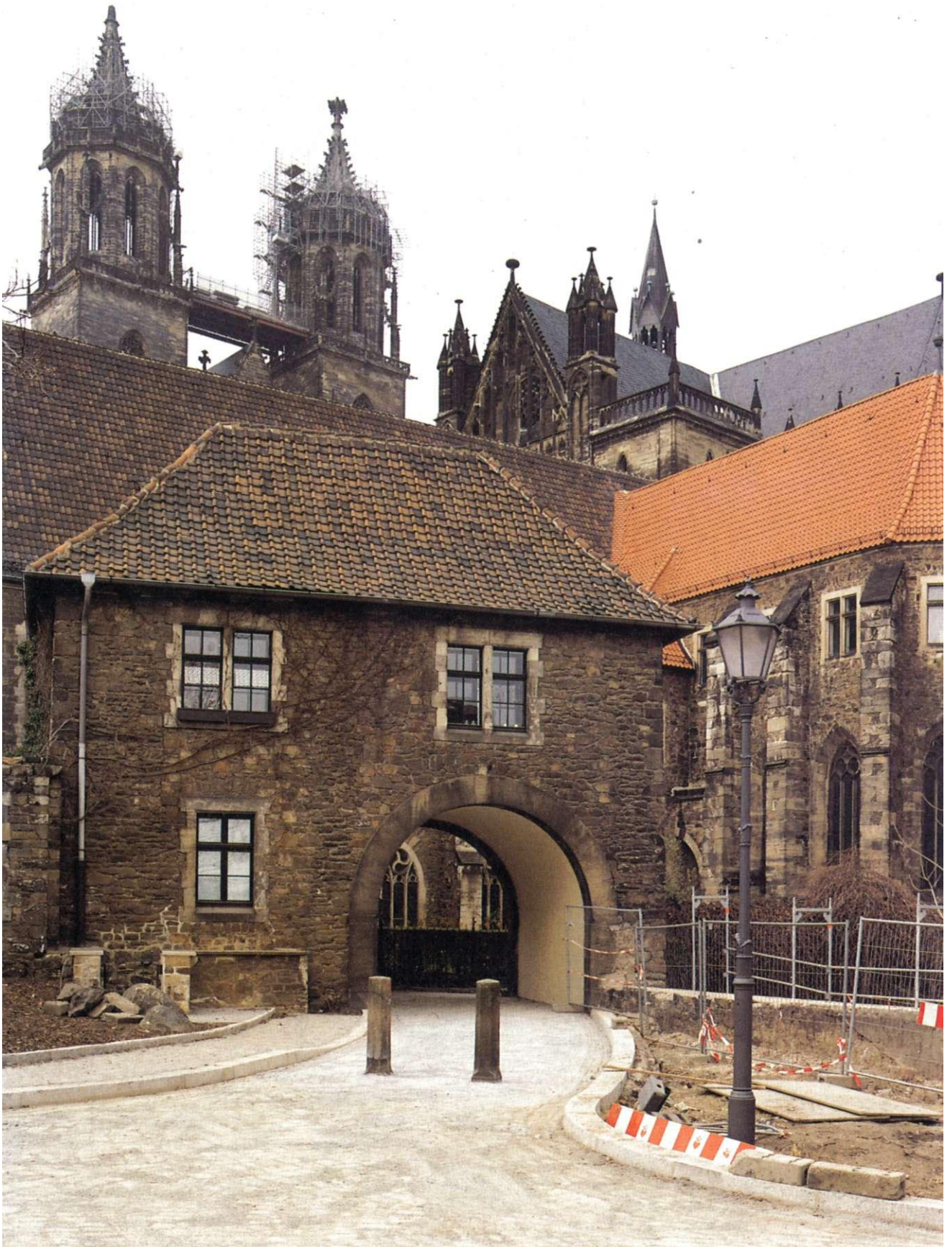
Neugestaltung des Domumfeldes 1998, Zugang zum Remtergang
