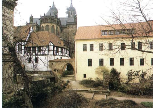
Möllenvogtei mit dem gotischen Stadttor während der Restaurierungsarbeiten 1998
