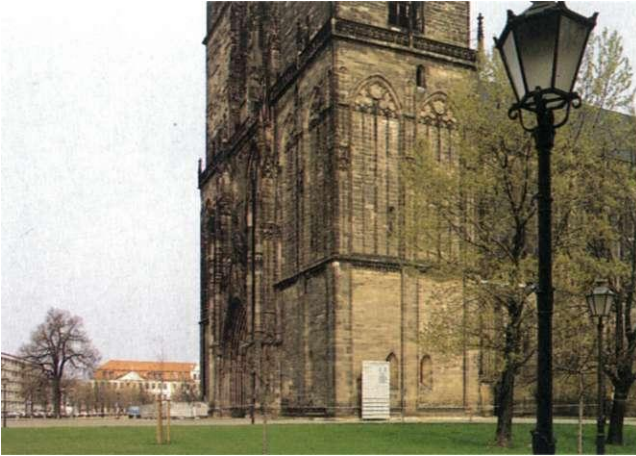
Blick zum Domplatz von der Danzstrasse 1998
