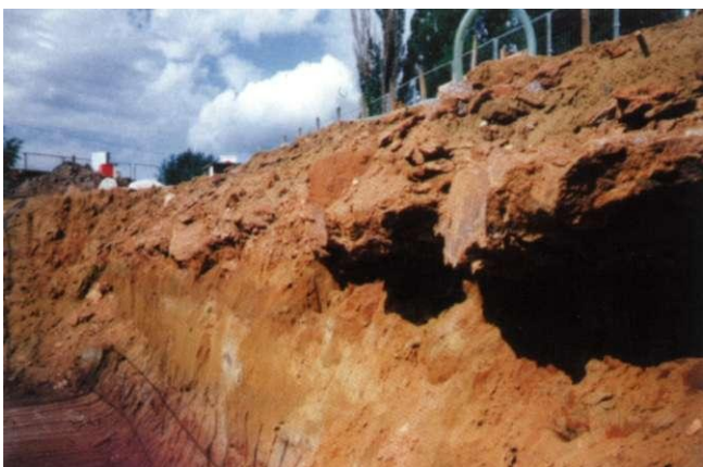
Abb. 7-5 "Grünsandplatten" in einer Baugrubenböschung am Lorenzweg
