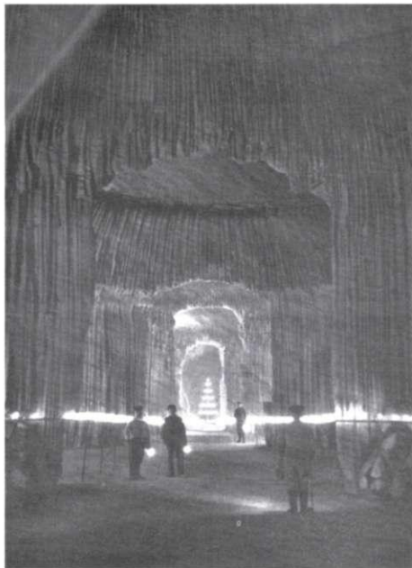
Abb. 6-2 Ausgesolte Glocken (Kali, verwandte Salze und Erdöl 1936)
