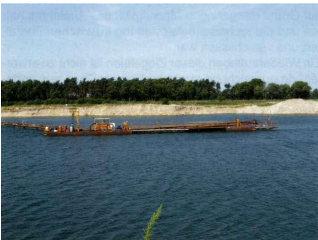
Abb. 8-1 Kiesabbau mittels Schwimmbagger
