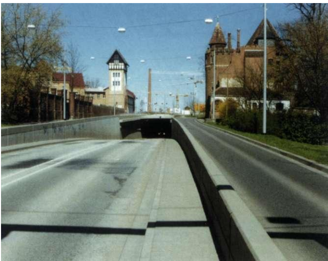
Abb. 12-12 Tunneleinfahrt von Süden, rechts die Lukasklause (Archiv Stadtplanungsamt)
