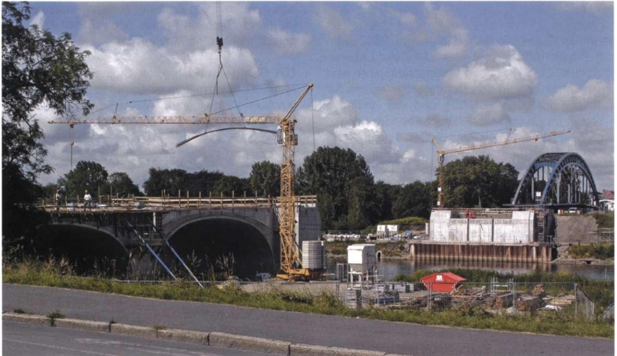
Abb. 14-8 Sternbrücke in der Bauphase (Archiv Stadtplanungsamt)
