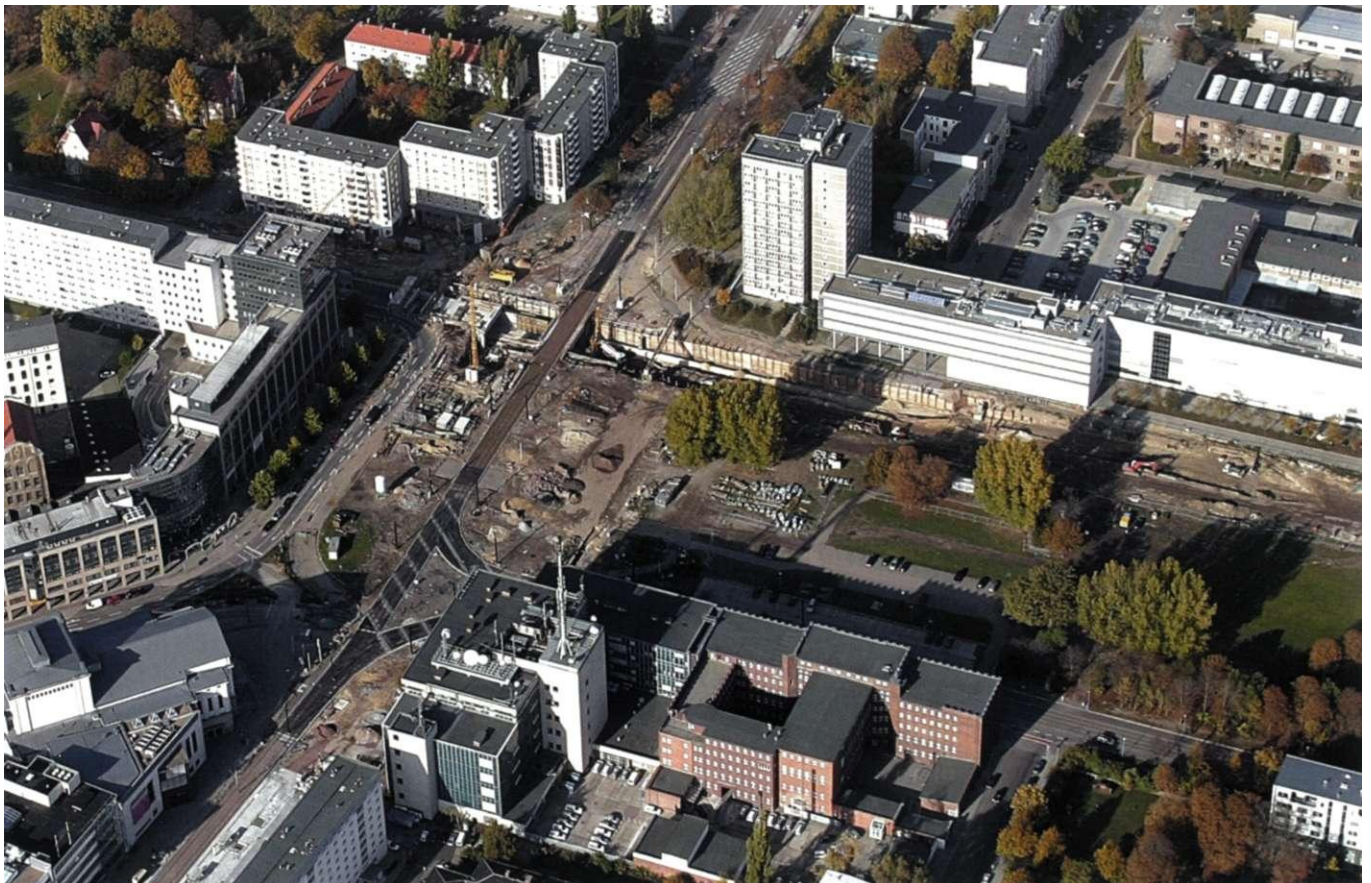
Abb. 12-1 Tunnelbaustelle Universitätsplatz, Blick nach Nordwesten (Archiv Stadtplanungsamt)
