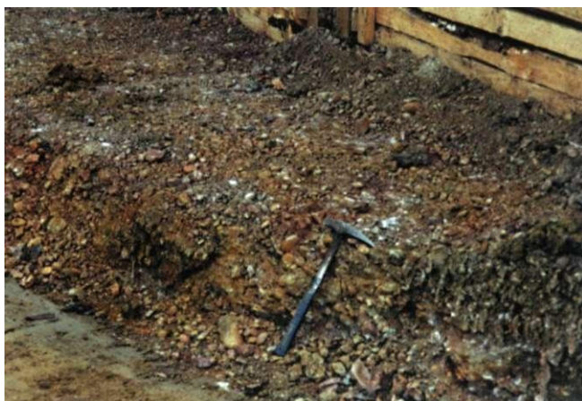
Abb. 12-3 Konglomerathorizont in der Tunnelsohle im Westteil
