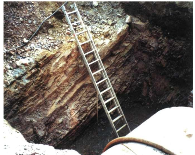
Abb. 12-4 Steilstehender Tonschiefer in Nähe des Abwasserkanals, Tunnelwestteil
