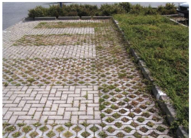
Abb. 9-7 Der Versiegelung entgegen wirken - Rasengittersteine und Begleitgrün auf Parkplätzen. Parkplatz Bördepark, Juni 2005
