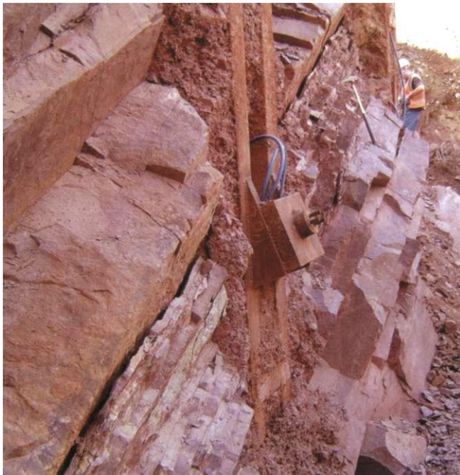
Abb. 12-3 Konglomerathorizont in der Tunnelsohle im Westteil
