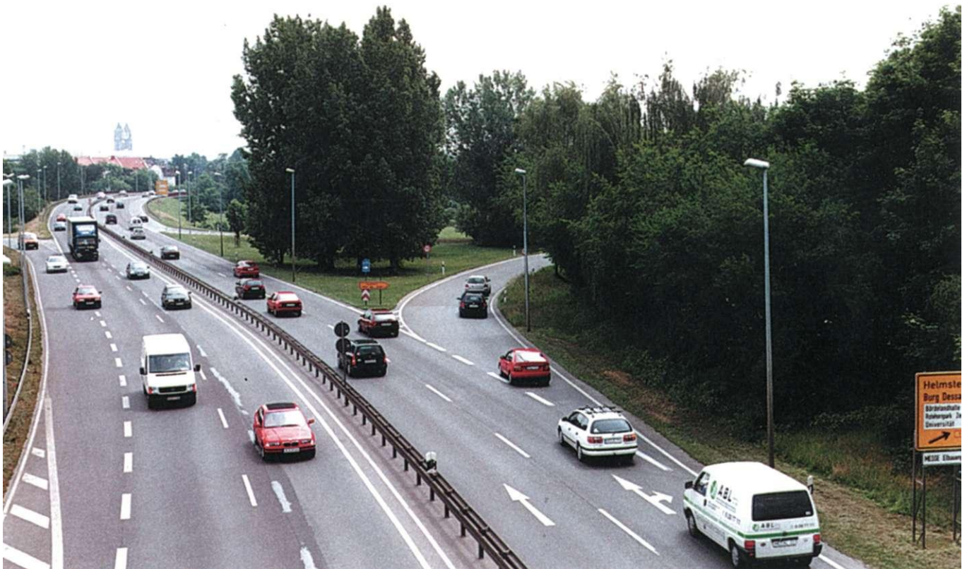
Magdeburger Ring 2001 - Blick von der Brücke Lorenzweg nach Süden
