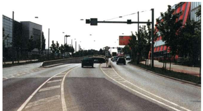
Tunnel Askanischer Platz
