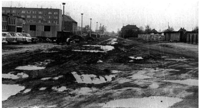
Landsbergstraße, heute Albert-Vater-Straße, vor dem Ausbau um 1975
