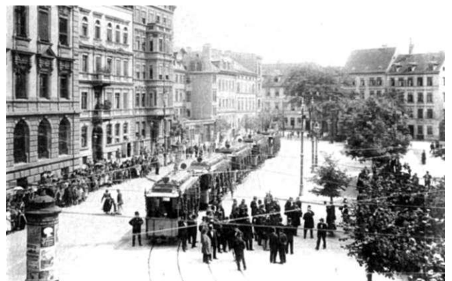
Eröffnung des elektrischen Betriebes auf dem Johanniskirchhof am 17.07.1899
