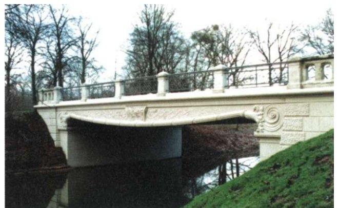
Restaurierte Reyherbrücke im Stadtpark Rotehorn
