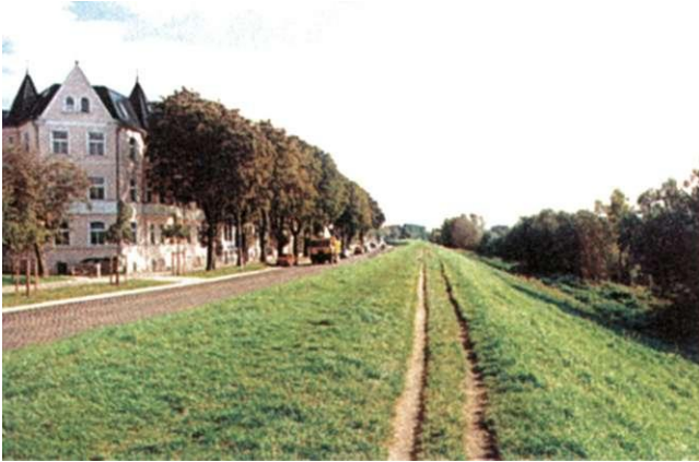
Elberadweg auf dem Deich / Büchnerstraße vorheriger Zustand
