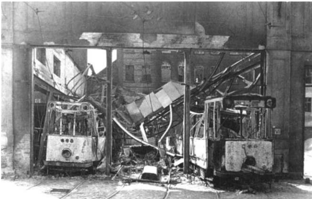
Am 5.8.1944 wurde das Depot Neustadt in der Lübecker Straße total zerstört
