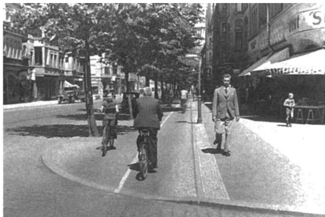
Radweg (Zweirichtungsradweg!) Lüneburger Straße
