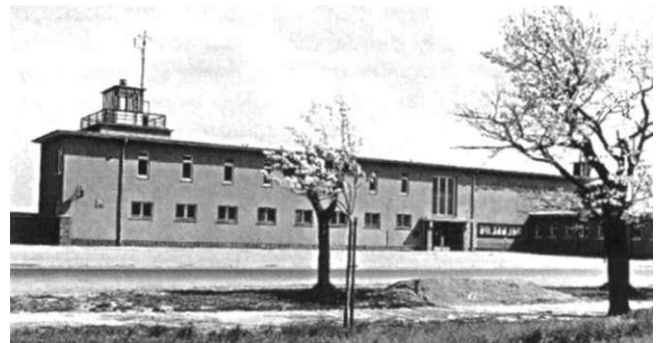
Das Gaststätten- und Verwaltungsgebäude prägt noch heute das Bild der Leipziger Straße
