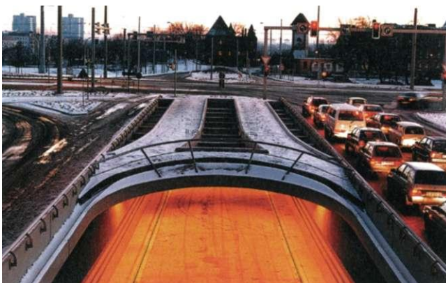
Nördliche Tunneleinfahrt am Askanischen Platz
