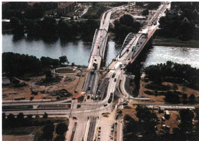
Nordbrückenzug: Im Vordergrund Askanischer Platz in der Bauphase; alte und neue Jerusalembrücke
