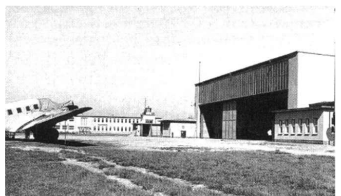
Zum Unterstellen der Maschinen wurde schon in den 30er Jahren eine Flugzeughalle gebaut.
