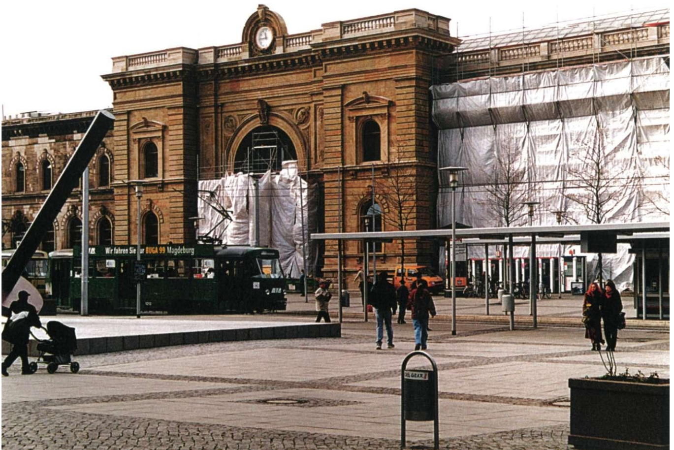
Bahnhofsvorplatz während der Sanierung der Bahnhofsfassade (1999/2000)
