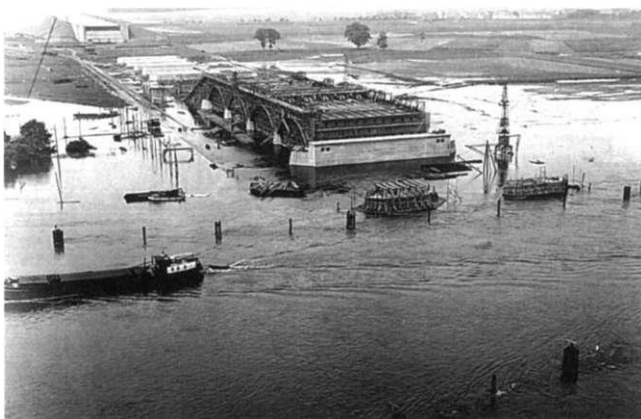
Widerlager West der Vorlandbrücke
