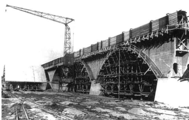
Links erkennbar die verfahrbare Schalung zur Ausbildung der Bögen
