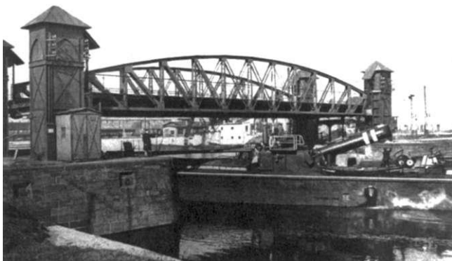
Hubbrücke im Handelshafen in angehobenem Zustande
