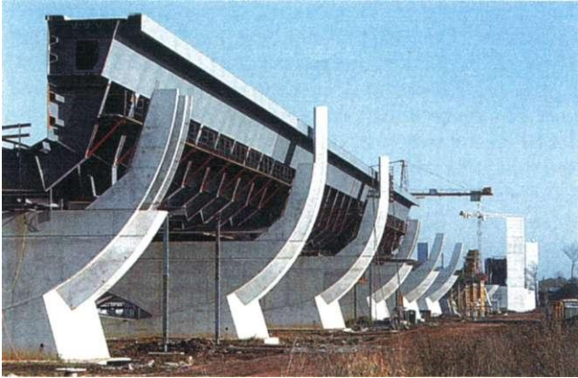
Vorlandbrücke mit spantenförmigen Pfeilen
