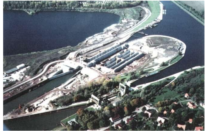
Schiffshebewerk und Sparschleuse Rothensee
