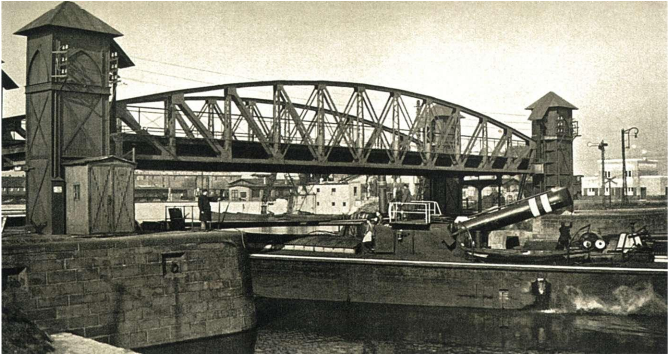
Hubbrücke im Handelshafen in angehobenen Zustand
