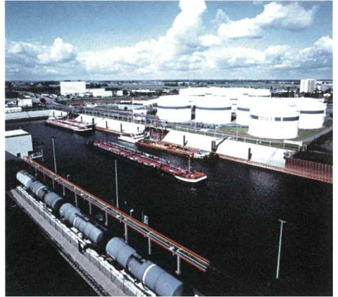
Das Hafenbecken II nach den Ausbaurbeiten und der Firmenansiedlung 1997
