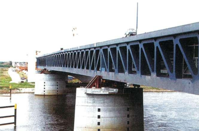
Strombrücke, Außenkonstruktion als Fachwerkträger
