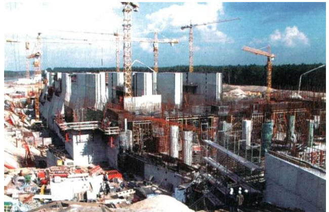
Betonage der Schleusenammern in Hohenwarthe
