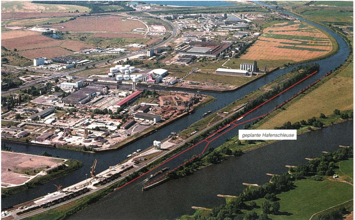
Magdeburger Kanalhafen und Rothenseer Verbindungskanal, Juni 1999
