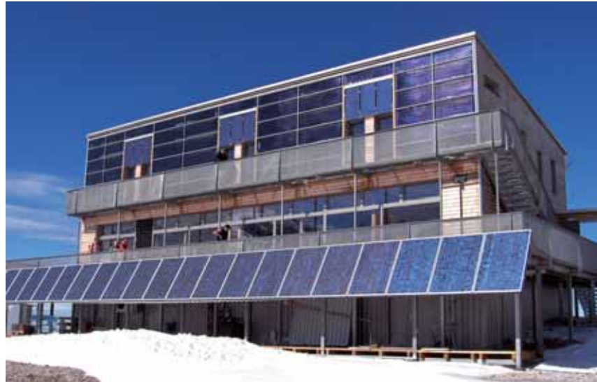
Abb. 11: Der Entwurf für die Schutzhütte Schiestlhaus, ein Passivhaus am Hochschwab in 2.145 m Höhe, wurden nach den klimatischen Bedingungen ausgerichtet und die Orientierung der Fenster und Verschattungselemente entsprechend nach Süden ausgerichtet.
