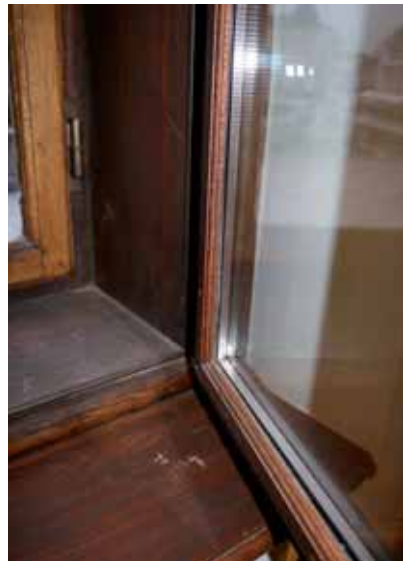
Abb. 48: Fensteransicht außen vor der Sanierung (links) / Innenflügel mit Zweischeibenwärmeschutzverglasung nach der Sanierung (rechts)
