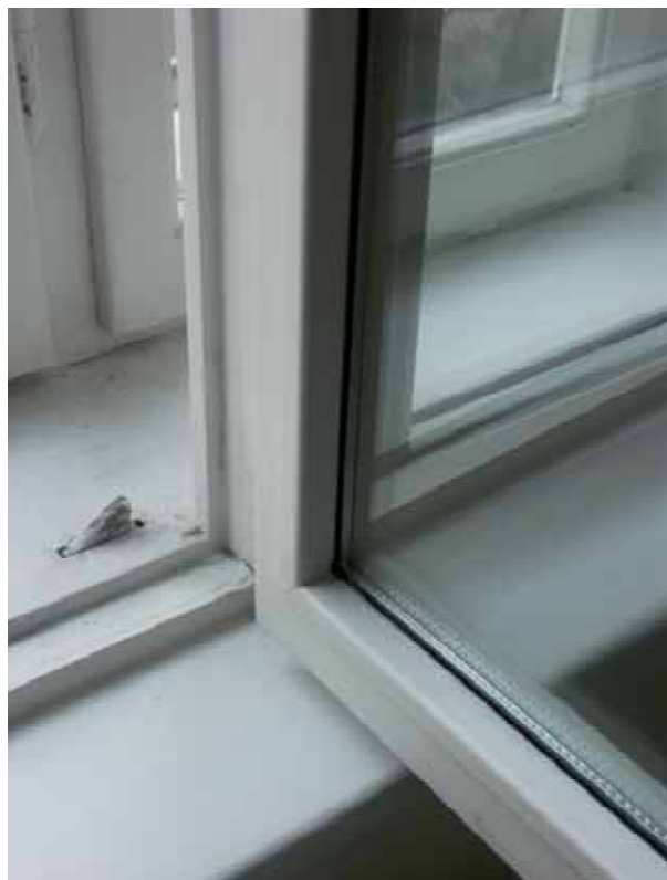
Abb. 73: Fensterdetail nach der Sanierung
