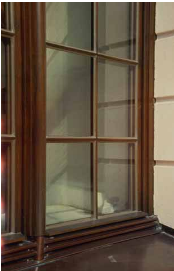
Abb. 55 Detail: Historisches Fenster Ansicht außen
