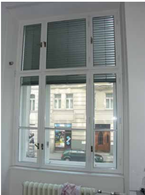
Abb. 72: Fensteransicht innen nach der Sanierung
