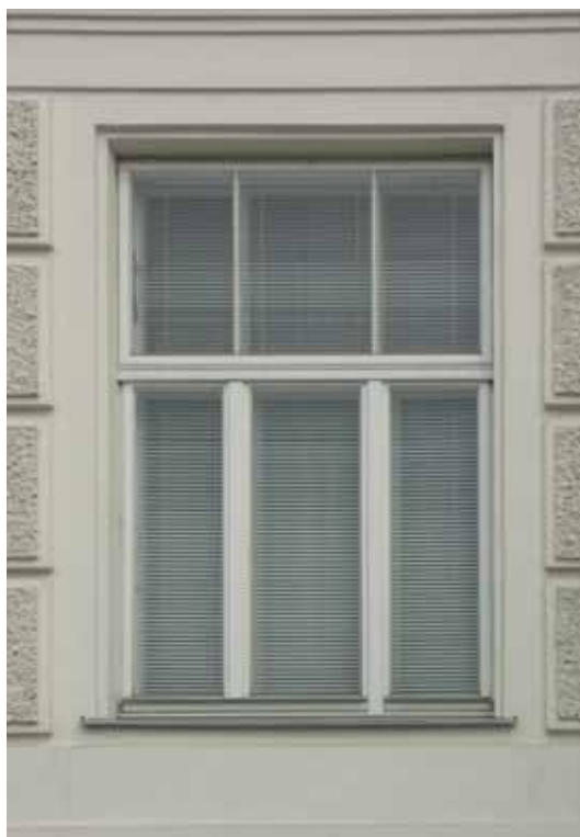
Abb. 76: Außenansicht Fenster mit Sonnenschutz im Kastenfensterzwischenraum
