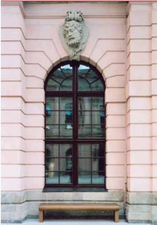
Abb. 54: Historisches Fenster Ansicht außen
