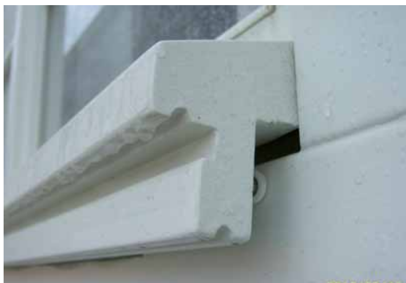
Abb. 63: Überstromschlitz im unteren Teil des Blendrahmens unter dem Wetterschenkel
