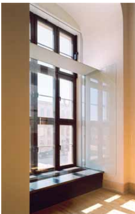
Abb. 59: Fenster im Obergeschoß mit neuem Ganzglasflügel, „lightshelf“ und Brüstungsverkleidung mit Klimaaggregaten
