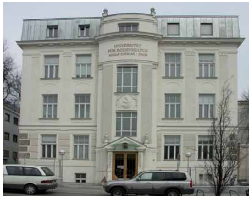
Abb. 74: Ansicht Cieslar Haus nach der Sanierung
