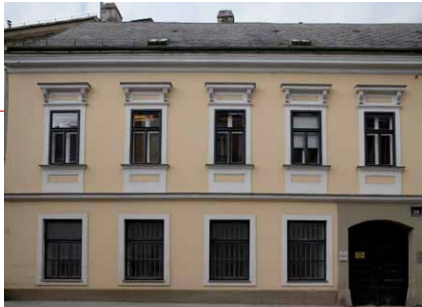
Abb. 43: Ansicht Haus Penzingerstraße nach der Sanierung
