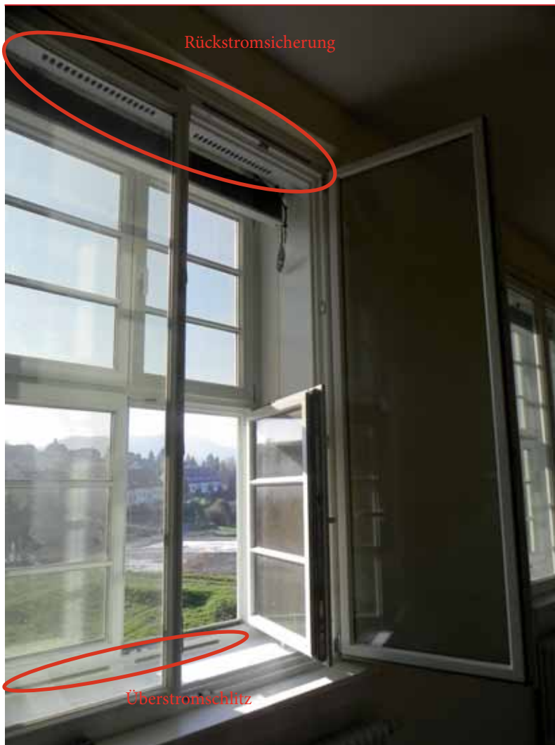
Abb. 62: Zuluft-Kastenfenster
