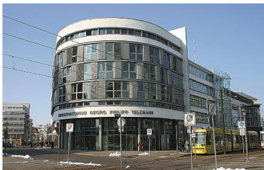
Konservatorium „Georg Philipp Telemann“
