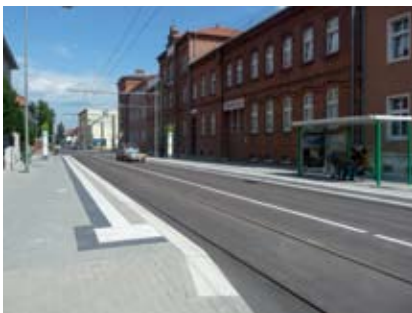
Barrierefrei ausgebaute Haltestelle Pfeifferstraße (2010)
