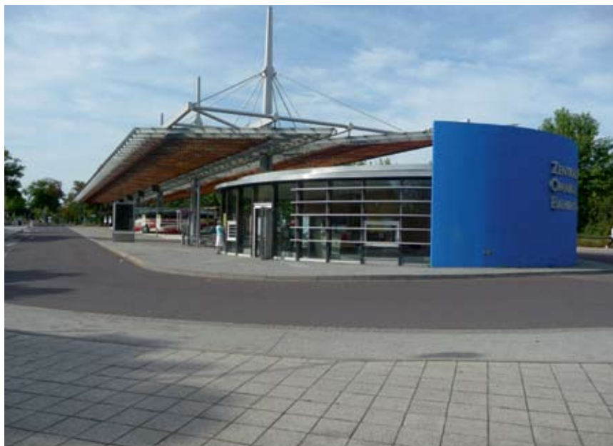
Zentraler Omnibusbahnhof Magdeburg (2009)
