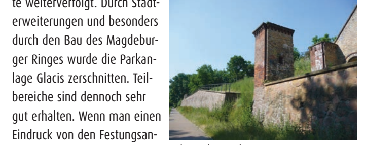
Anlagen der Kernfestung West
