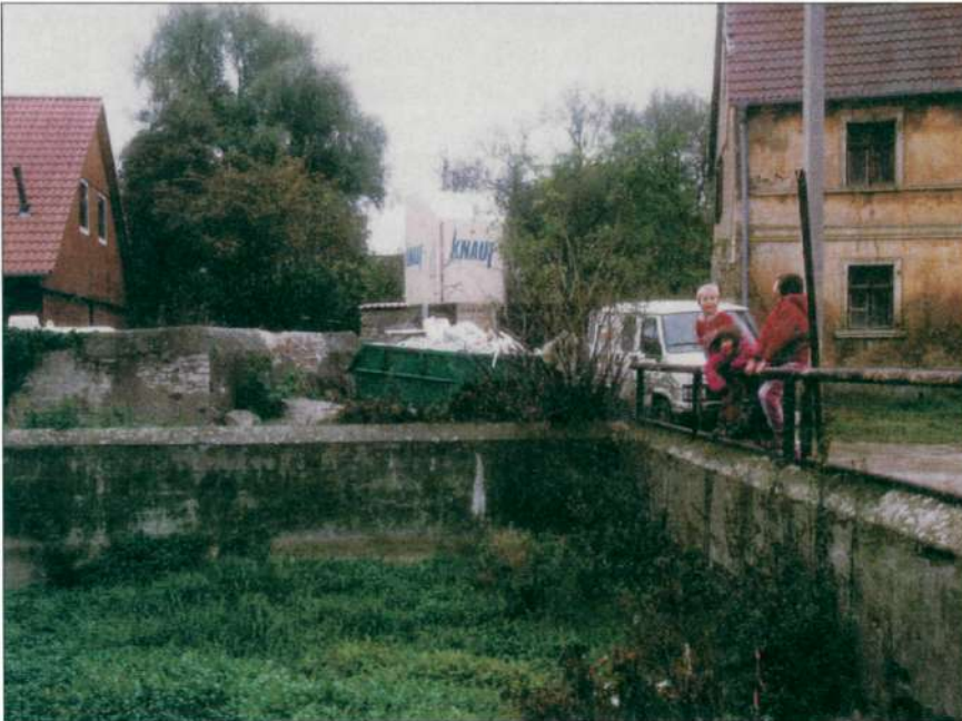
Beispiel Dorfteich: Einbetonierung und Vermauerung von Dorfteich und Quellen sind nicht nur aus hydrologischer Sicht bedenklich.
