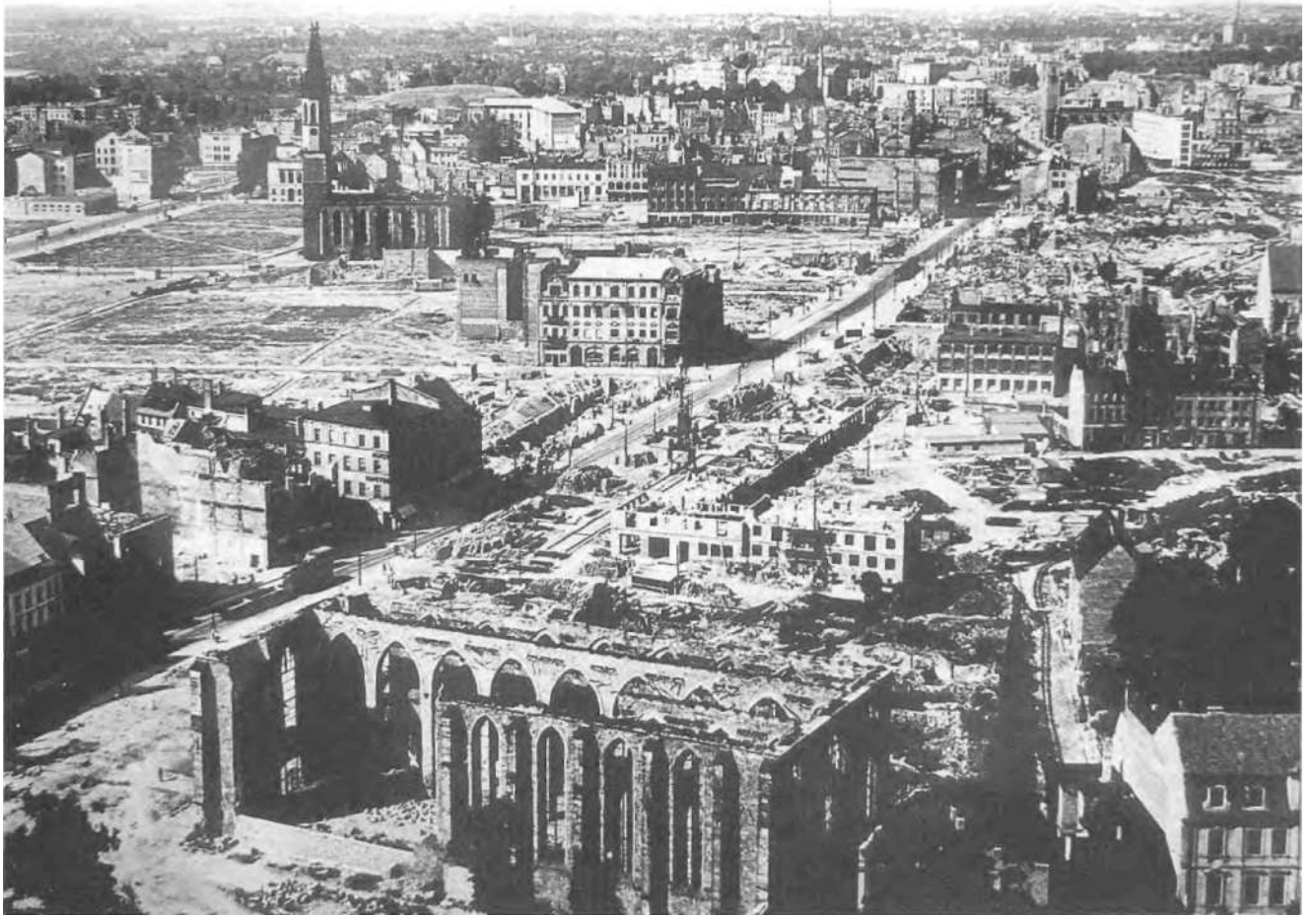
Blick auf die Kirchenruinen nach der Zerstörung 1945
