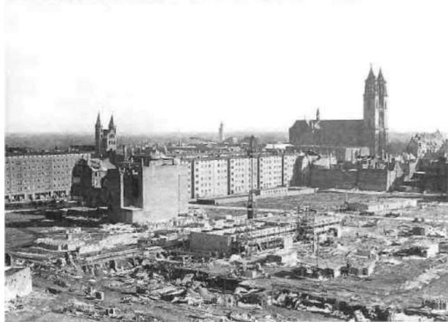
Baumaßnahmen im Bereich der Leiterstraße mit „freiem Blick“ auf den Dom
