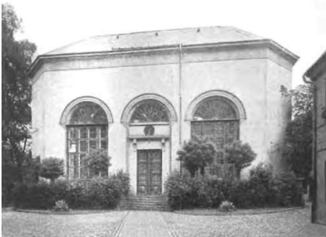
Außenansicht der französisch-reformierten Kirche (1806)
