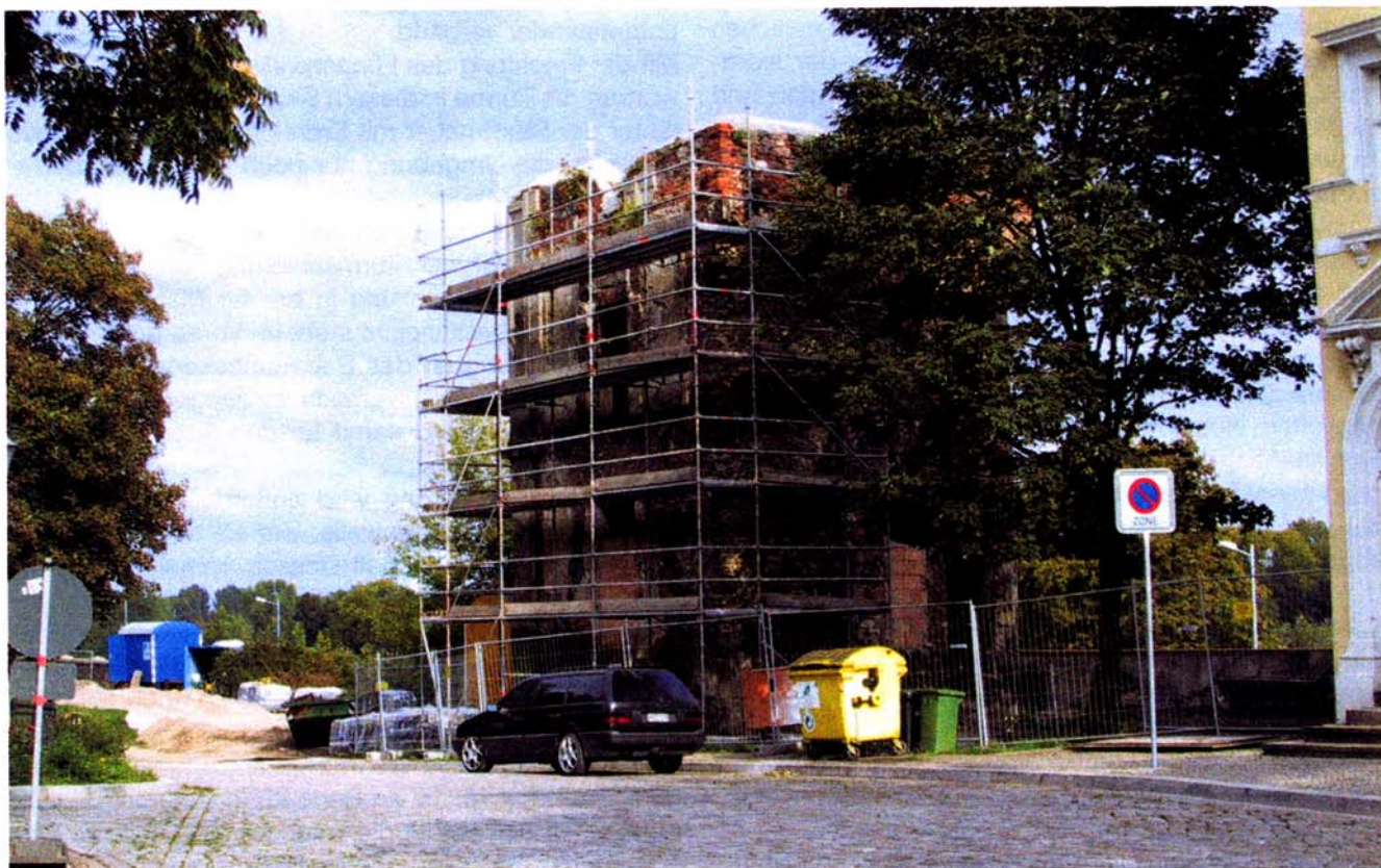
Turmuine, Fürstenwall 3 a, Einrüstung, Beginn der Sanierung
