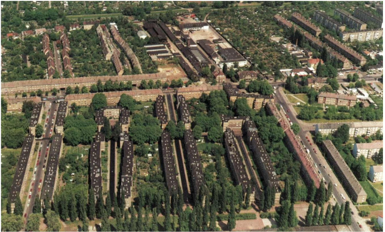
Luftbild der Siedlung Cracau von der Elbe (1993)
