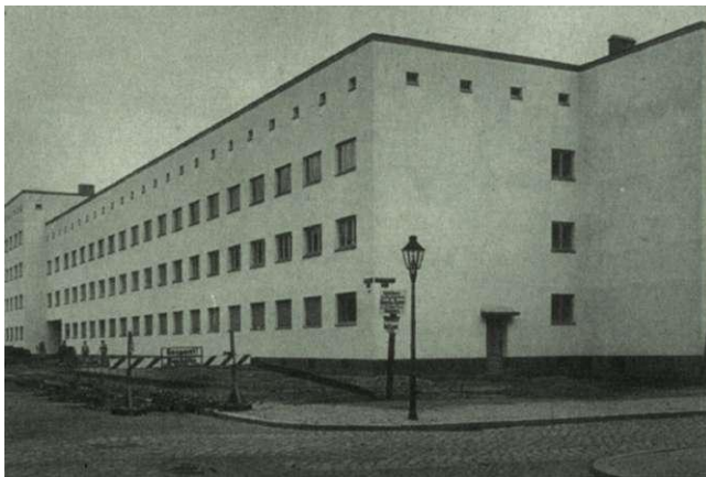
Laubenganghaus, Amsdorfstraße 5,6,7 (historische Aufnahme)
