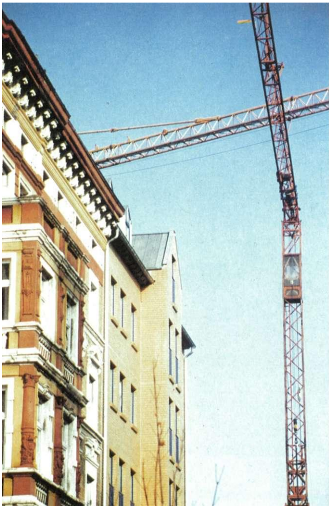
Bauaktivitäten an der Halberstädter Straße
