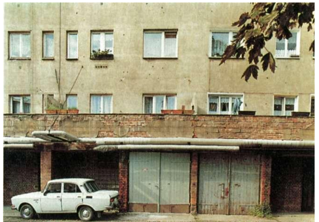
Abb. 53 1993. Georg-Heidler-Straße 4. Garagen im Hinterhaus.
