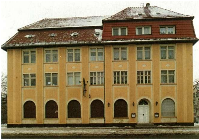
Abb. 8 Das alte Restaurant an der Jerichower Straße, frisch renoviert.
