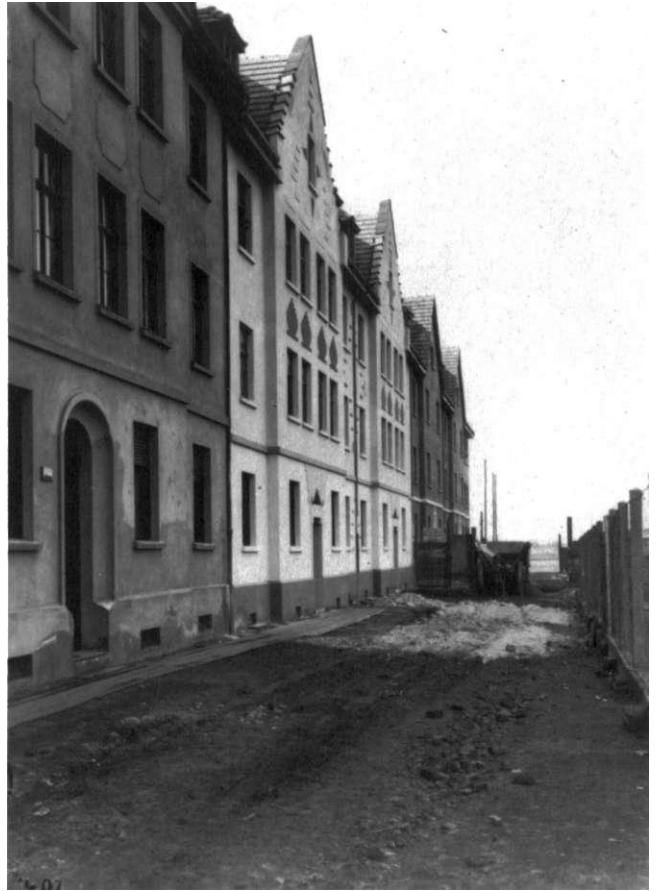
Abb. 111: 1921-1922. Wörlitzer Straße. Häuser des Mieter-Bau- und Sparvereins.
