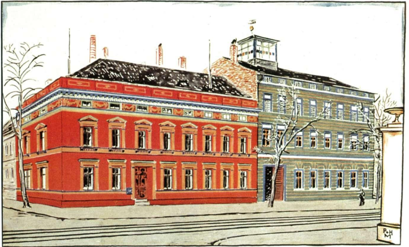
Abb. 107: Lübecker Straße, Ecke Mittagstraße: Häusergruppe der Firma J.G. Hauswaldt.
