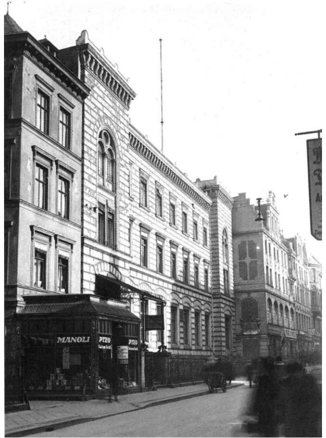
Abb. 120: 1923. Umbau der Alten Reichsbank zur Städt. Sparkasse. Ansicht Gr. Münzstrasse. "Die Architektur ist unter Erhaltung der Fenster und der Massengliederungen vollständig verändert worden und zwar so, dass sie dem Gefüge des Baukörpers folgt. (Wollen und Wirken, zu Bild 23) Fugen und Konsolengesimse sind verschwunden."
