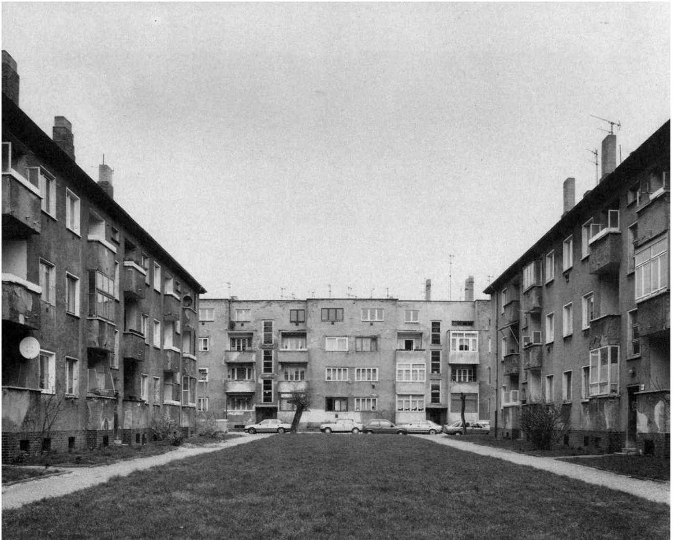
Balkonausbildung in den Bereichen 1 und 4 (Curiestraße)
