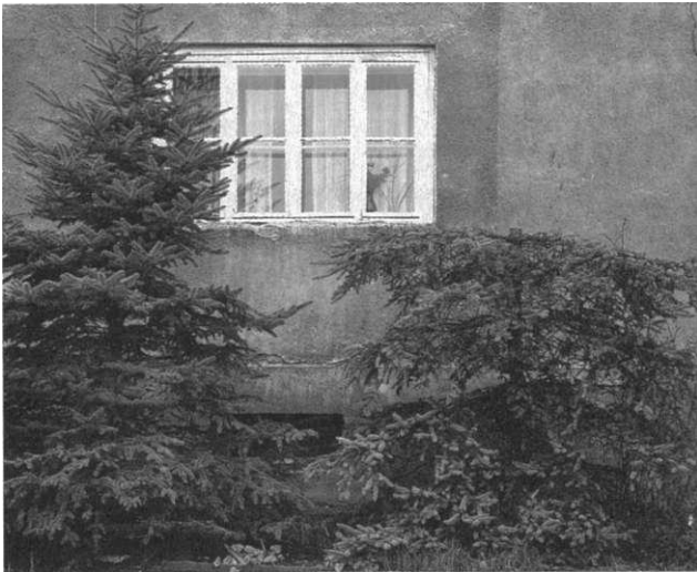
Wohnraumfenster im Bereich 1
