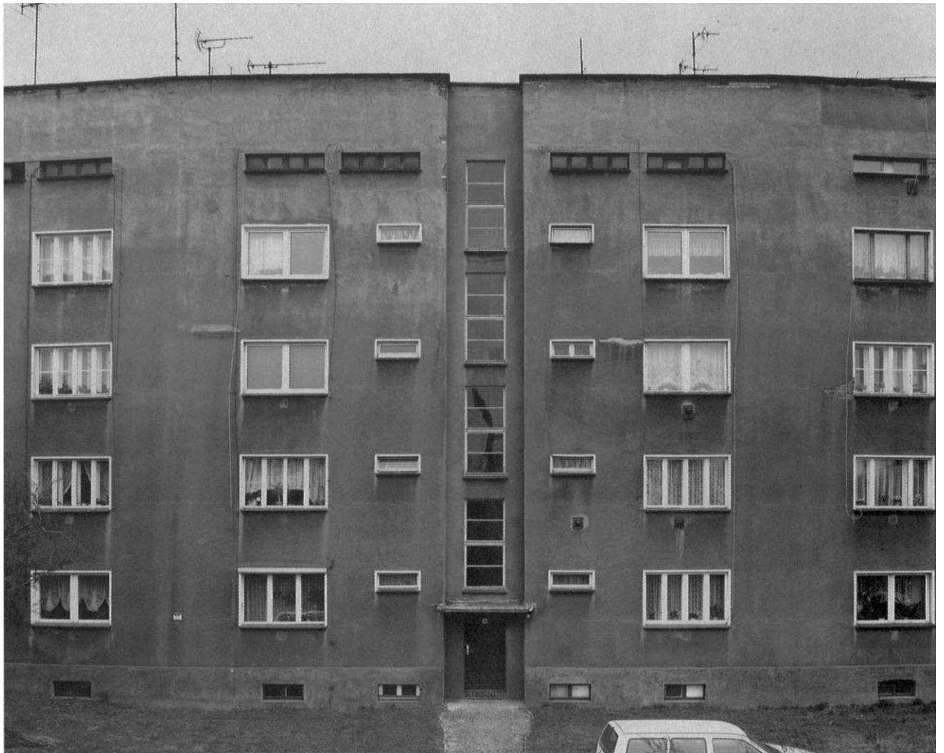
Fensterstruktur im TYP 1.3 (Bereich 1)
