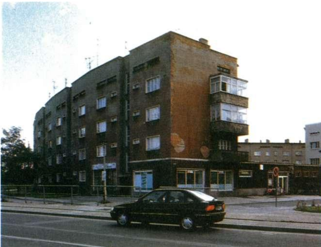
Kopfbau an der Rothenseer Straße, Ecke Reichelstraße, 1994
