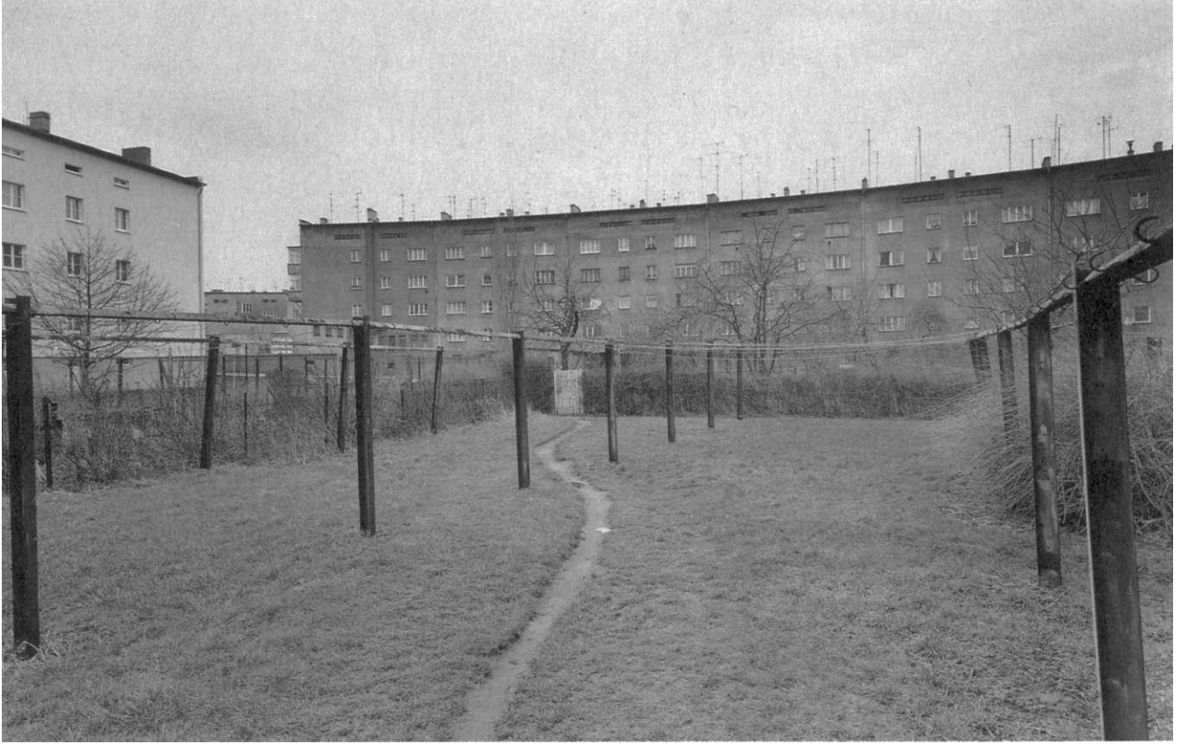
Wohnhof im Bereich 1
