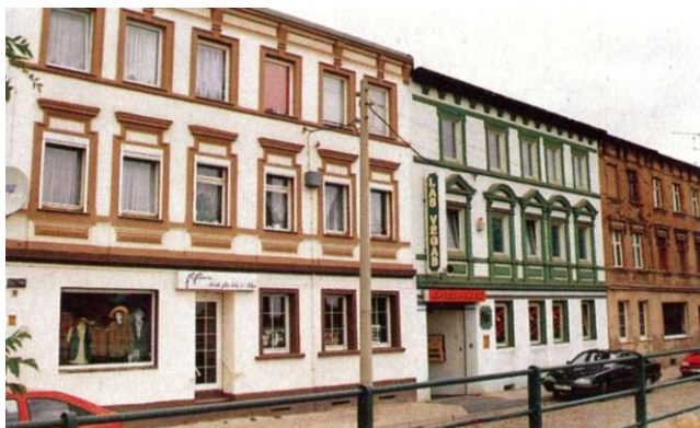
Abb. 35: Mietwohnhäuser in der Badeteichstraße, Baujahr um 1890
