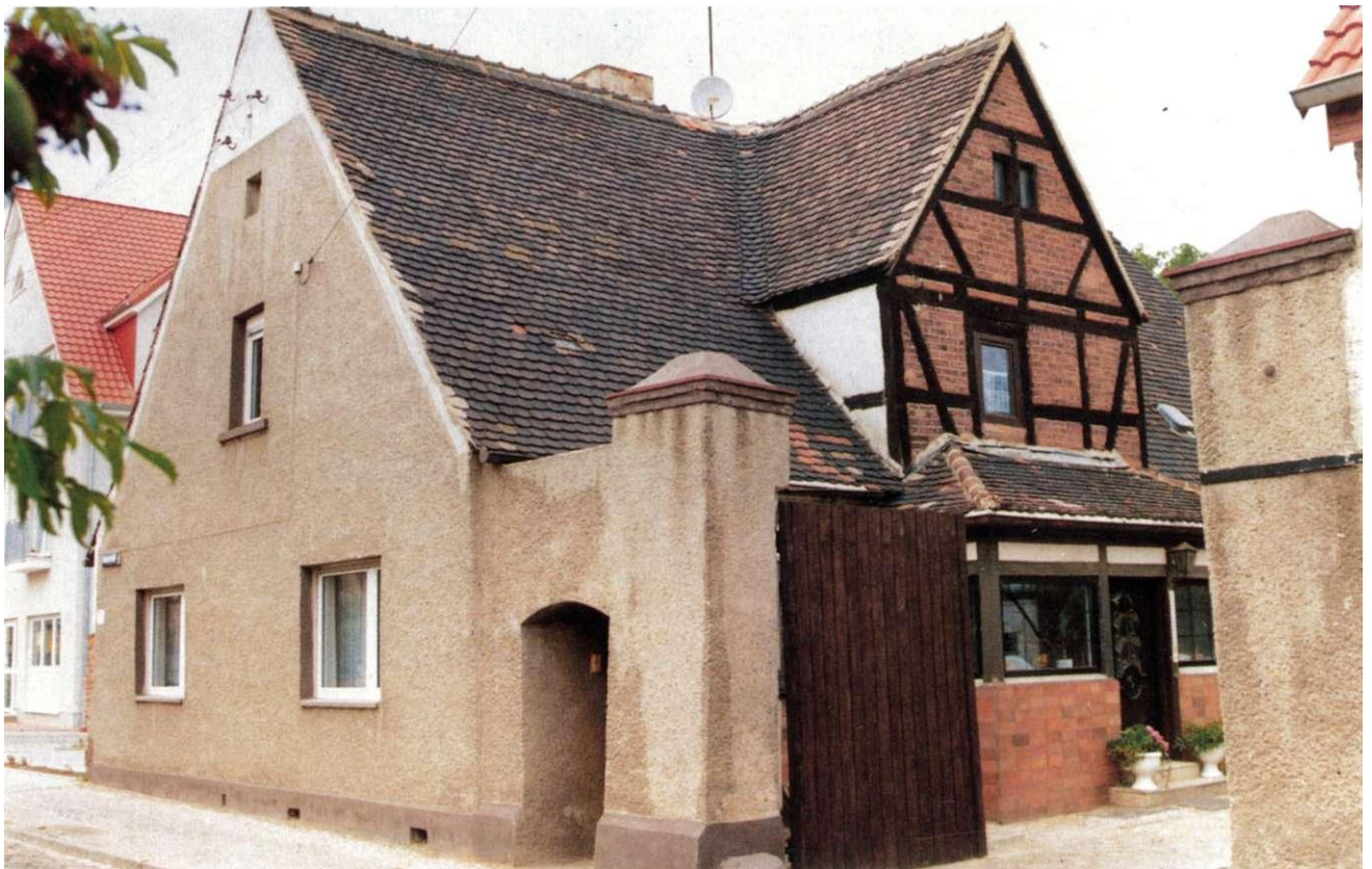
Abb. 33: Typisches Wohnhaus einer Hofanlage in der Badeteichstraße, Erbauungsjahr 1797
