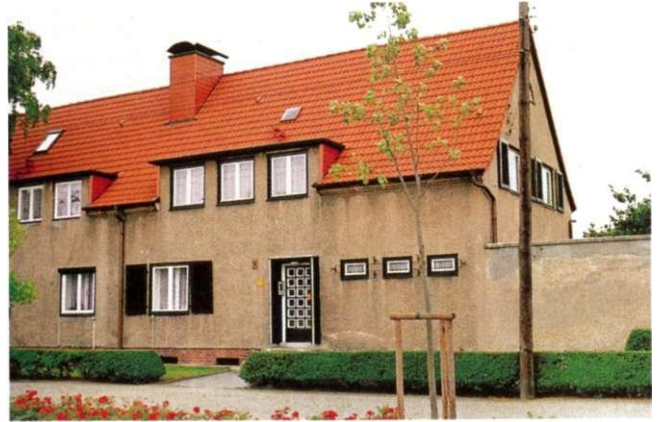
Abb. 38: Einfamilien Doppelhaus Hohenwarther Straße, Baujahr um 1938
