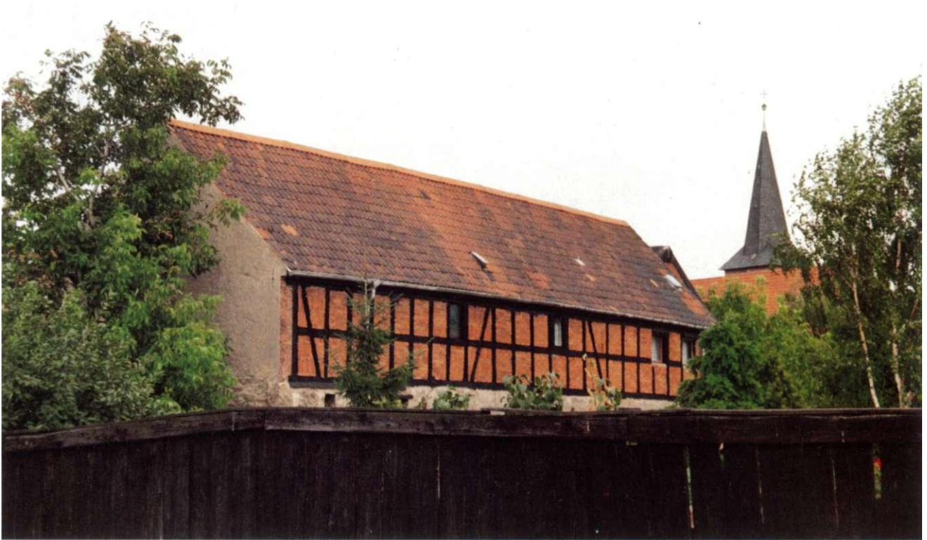
Abb. 34: Typische Scheune in Fachwerkbauweise
