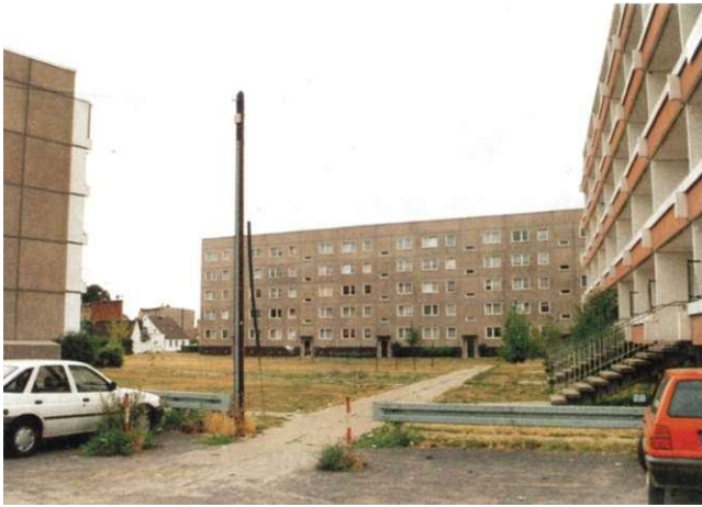
Abb. 44: Plattenbaukomplex der 80er Jahre
