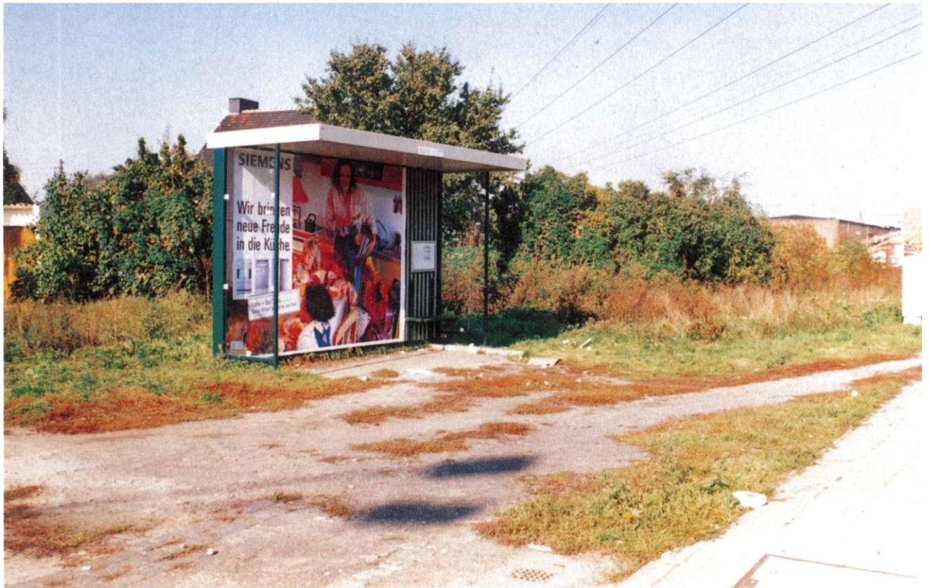
Abb. 47: Straßenbahnhaltstelle Hohenwarther Straße
