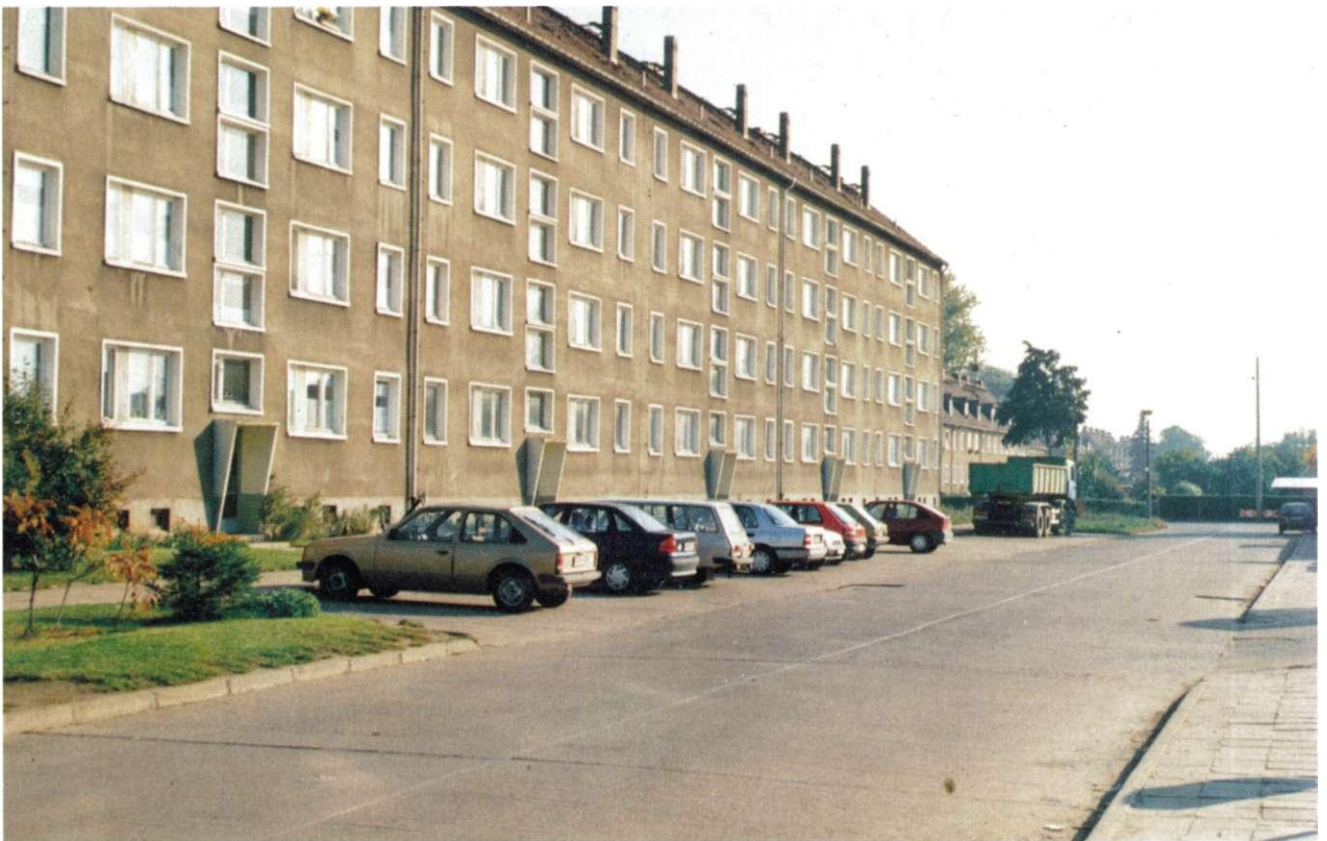
Abb. 52: Geordnetes Parken in der Jersleber Straße bei fehlender Begrünung
