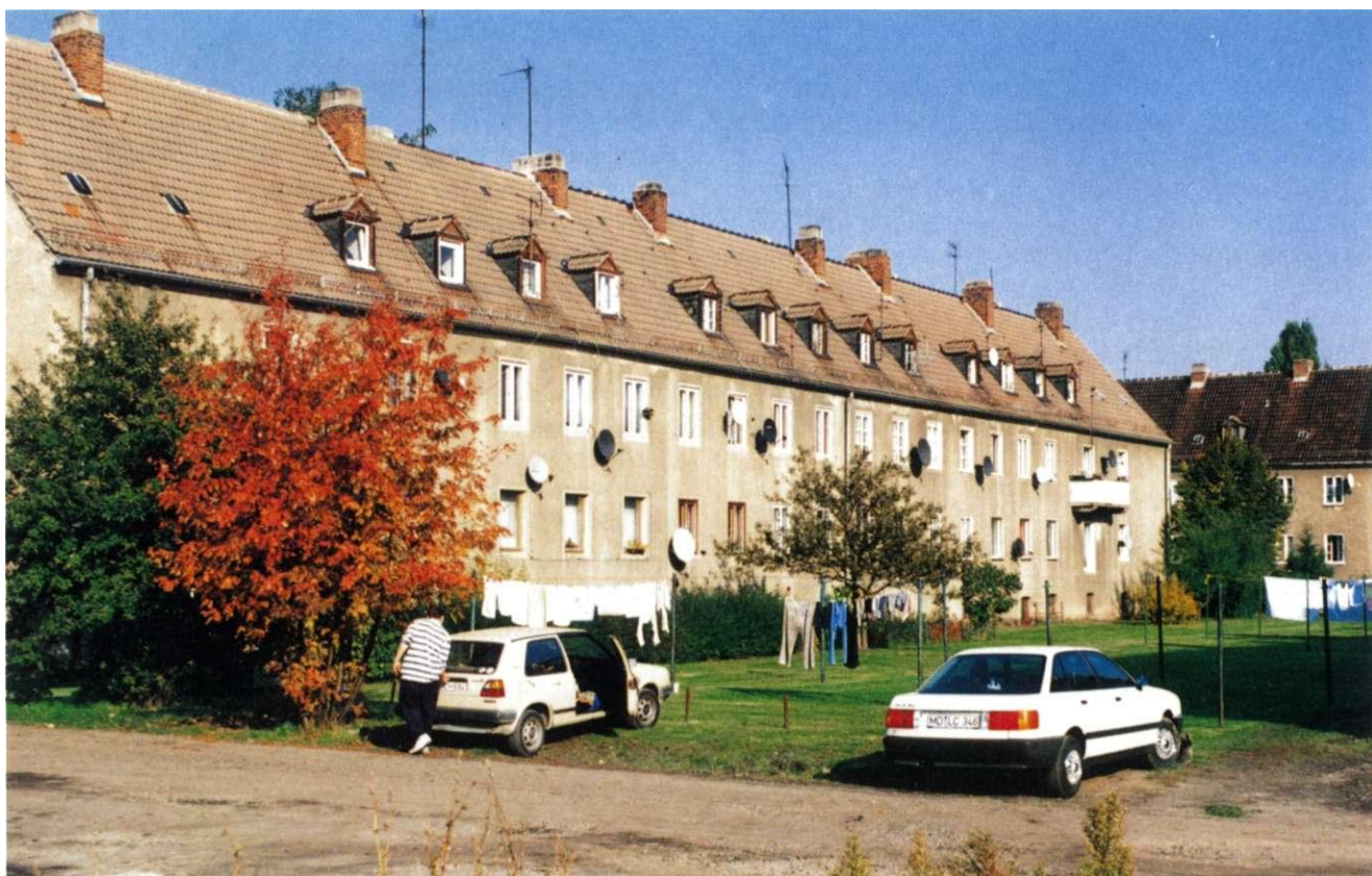
Abb. 42: Mietwohnhäuser der 30er Jahre an der Lindhorster Straße
