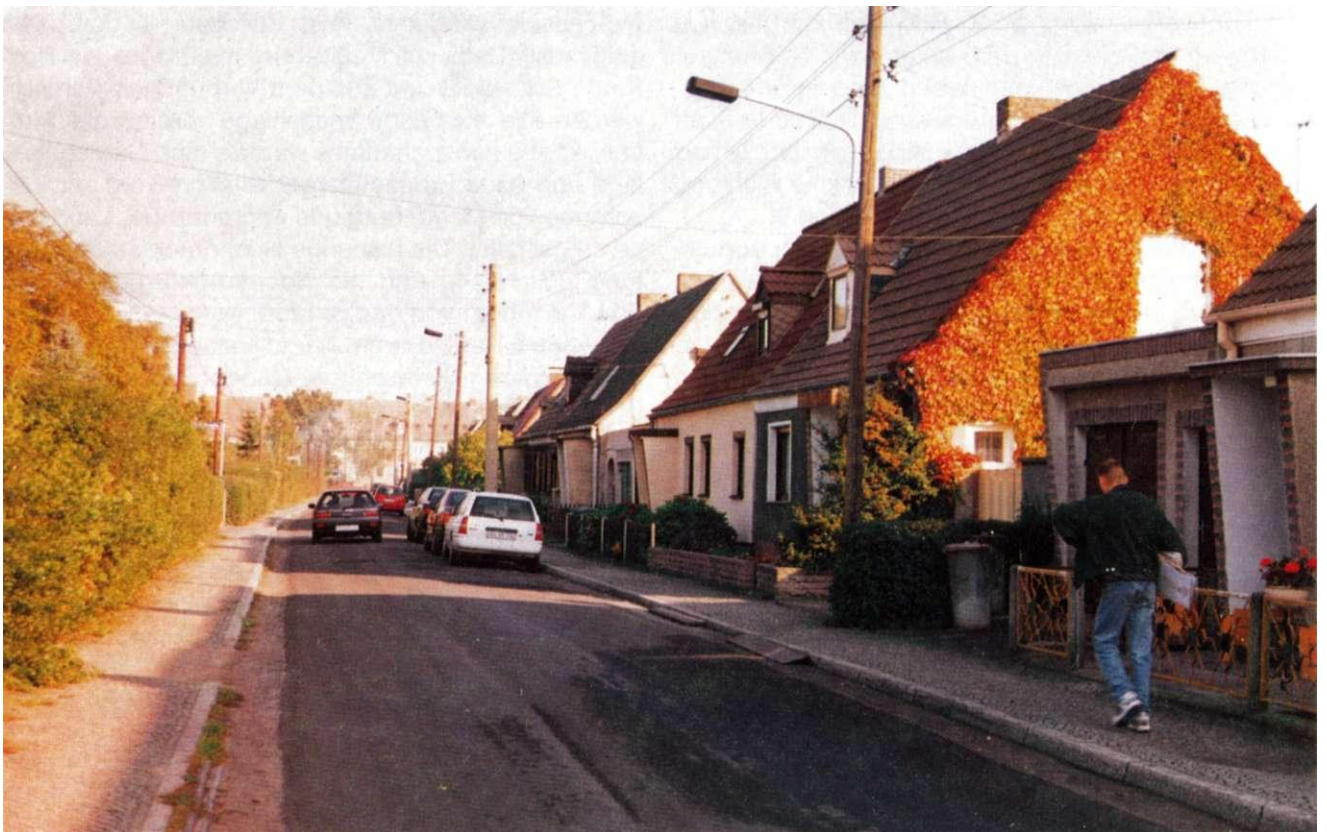
Abb. 73: Unzweckmäßige Auslegerleuchten an Leitungsmasten
