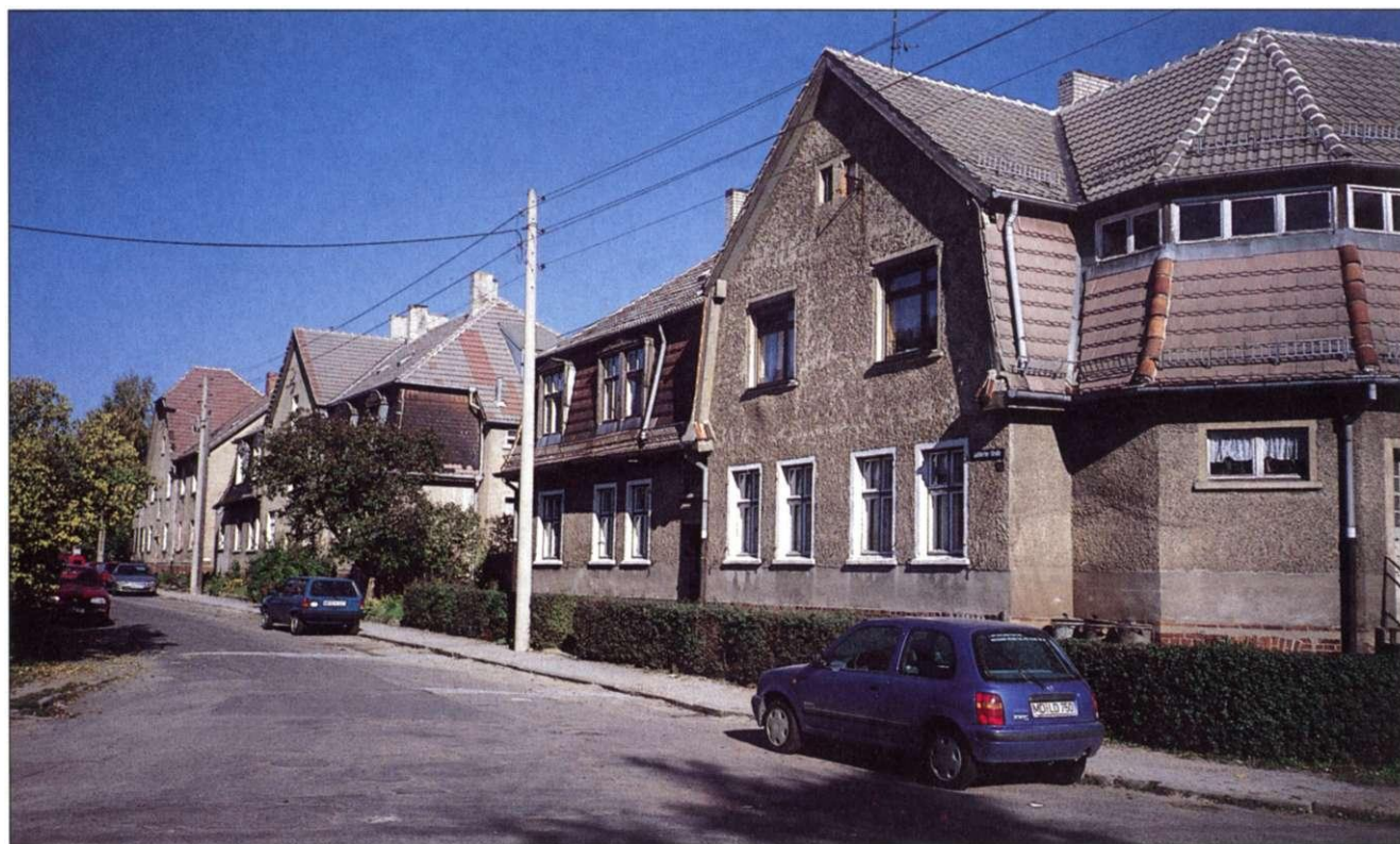
Kolonie Wolfsfelde: (Sülldorfer Straße): Geschloßwohnungsbau für Arbeiter und Werkmeister. Wie im Falle der Krupp-Gruson-Werkbeamten wurde die Siedlung mit Hilfe von Arbeitgeberdarlehen gegründet. Nach dem finanziellen Scheitern des Spar- und Bauvereins Wolfsfelde wurde sie jedoch von der Maschinenfabrik Wolf gekauft und bestand als klassische Werkssiedlung fort
