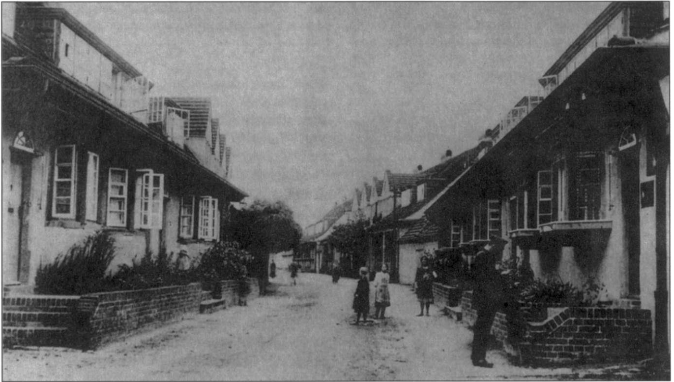
Die Gartenstadt Staaken: Vorindustriell anmutende Wohnidylle in einer Werksiedlung der Rüstungsindustrie im 1. Weltkrieg
