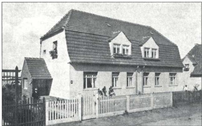
Doppelhaus Rosenweg 16/17, (Bj. 1910, Heim/Gieseler)
