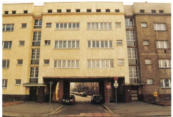
Abb. 35: Blick auf die Torsituation (Lucas-Cranach-Straße) von der Sudenburger Wuhne aus
