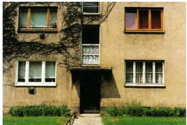
In Selbsthilfe ersetzte Fensterelemente
