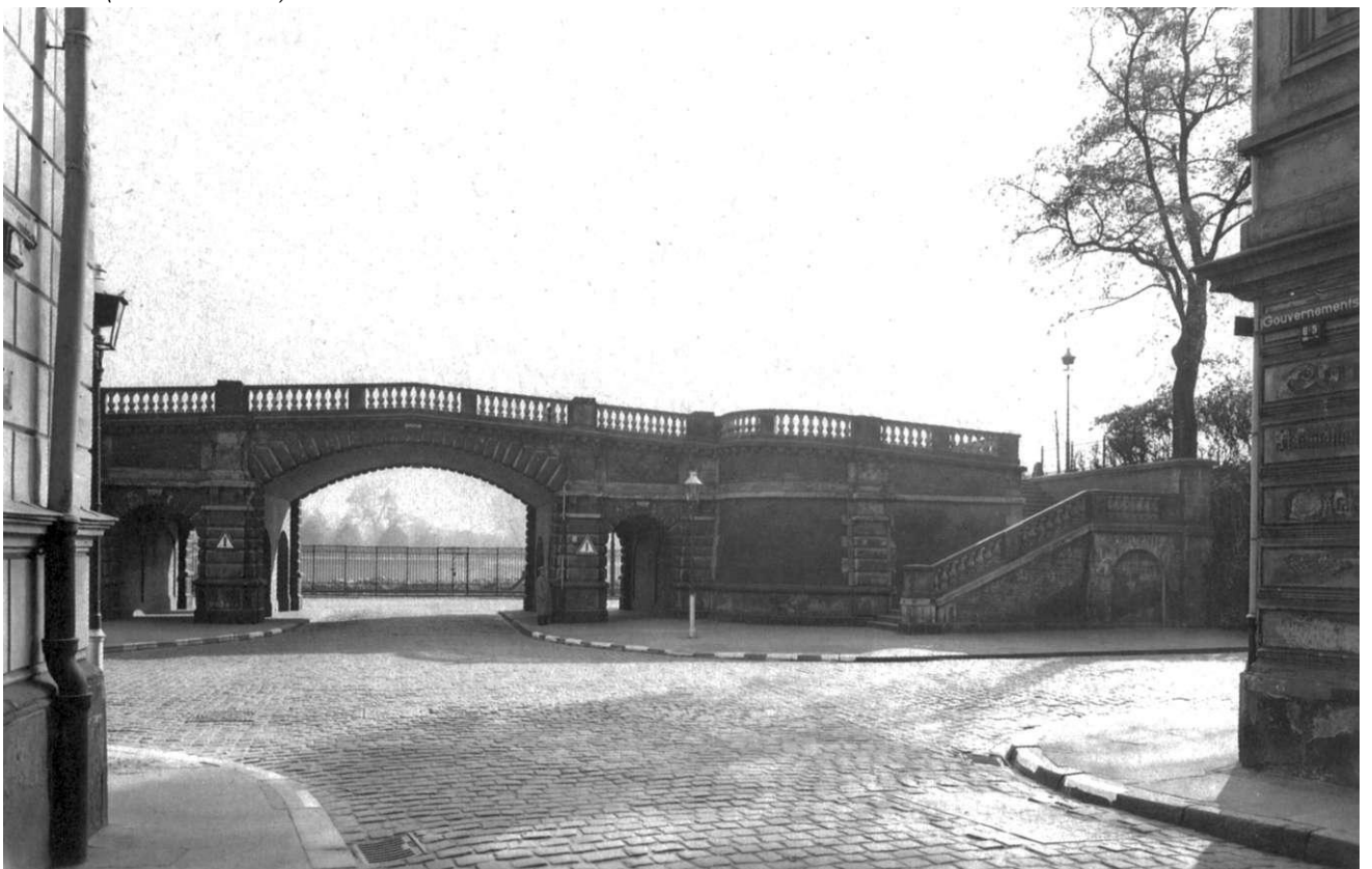
Abb. 16 Fürstenwallbrücke in Höhe des Gouvernementsberges (Blick nach Osten)
