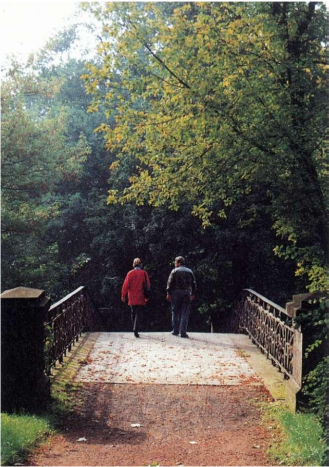
Abb. 109 Detail der Laaß-Brücke
