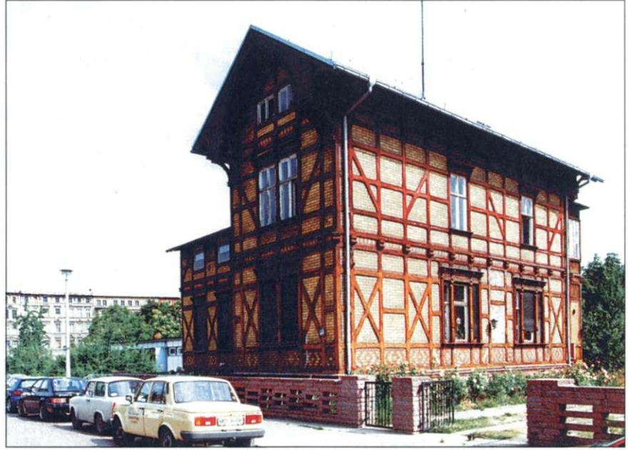
Abb. 26 Rayonhaus Steinigstraße 1a
