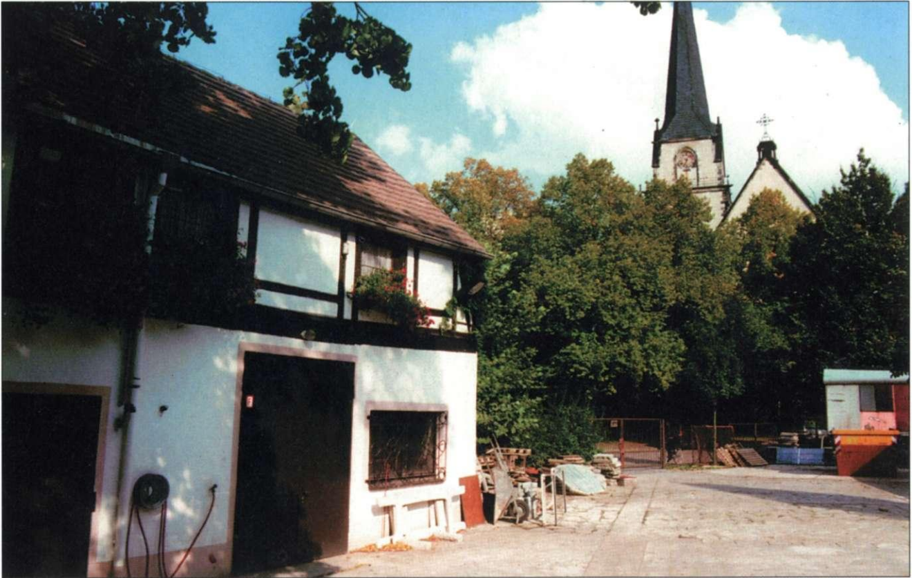
Abb. 41 1866 errichtetes Werkstattgebäude Liebermannstraße 13
