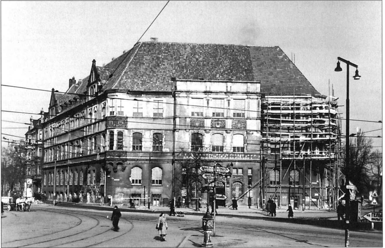
Abb. 2 Wilhelma-Gebäude, Aufnahme vom 29.3.1949
