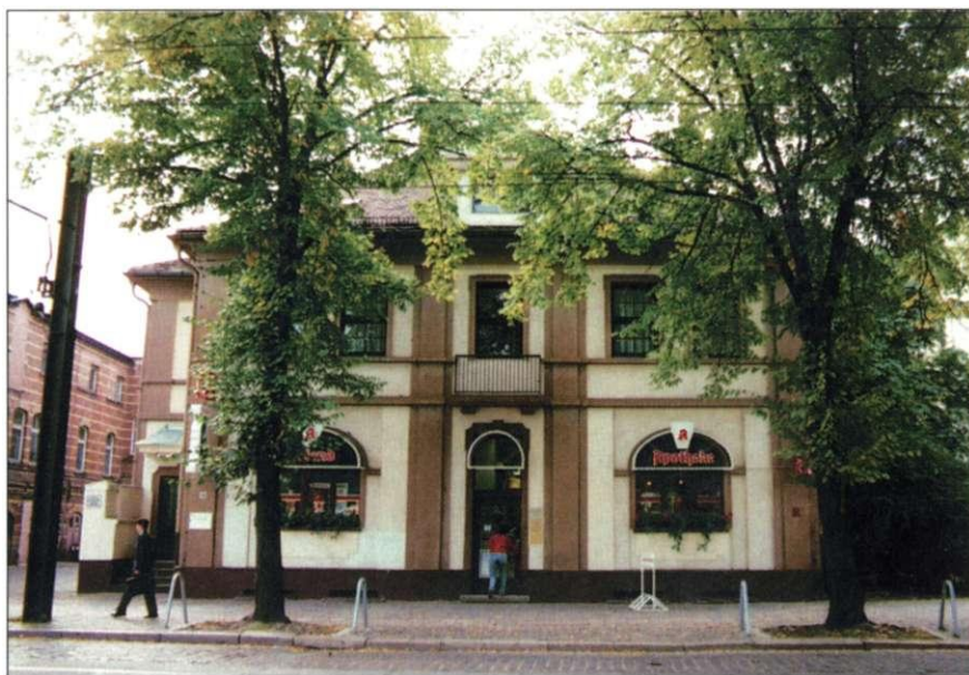
Abb. 36 Das stark veränderte Wohnhaus Olvenstedter Straße 48 in heutigem Zustand
