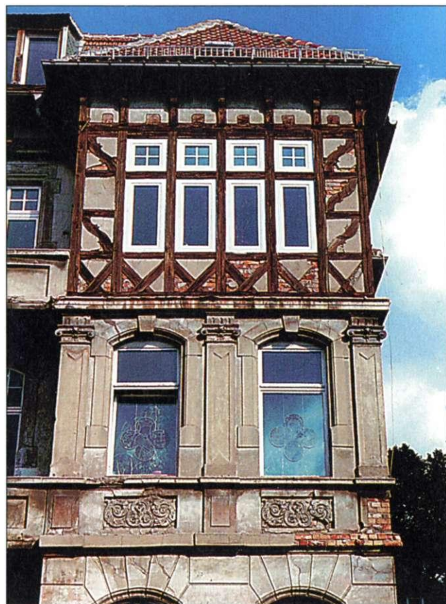
Abb. 119 Goethestraße 39, rechter äußerer Risalit
