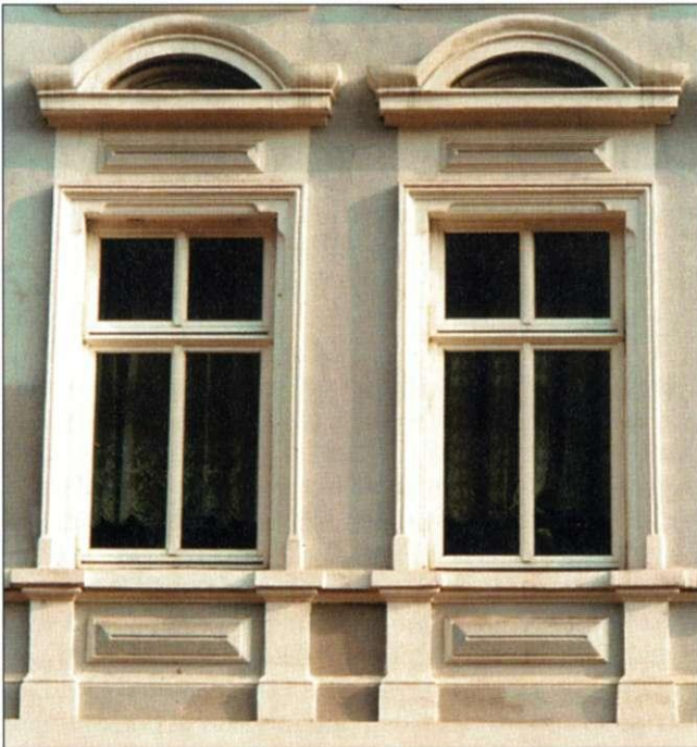
Abb. 80 Immermannstraße 15, schlichte Fensterarchitektur mit Diamantquadern an den Fensterbrüstungen und unterhalb der Segmentgiebel
