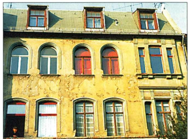
Abb. 112 Friesenstraße 58, Obergeschosse und Dach
