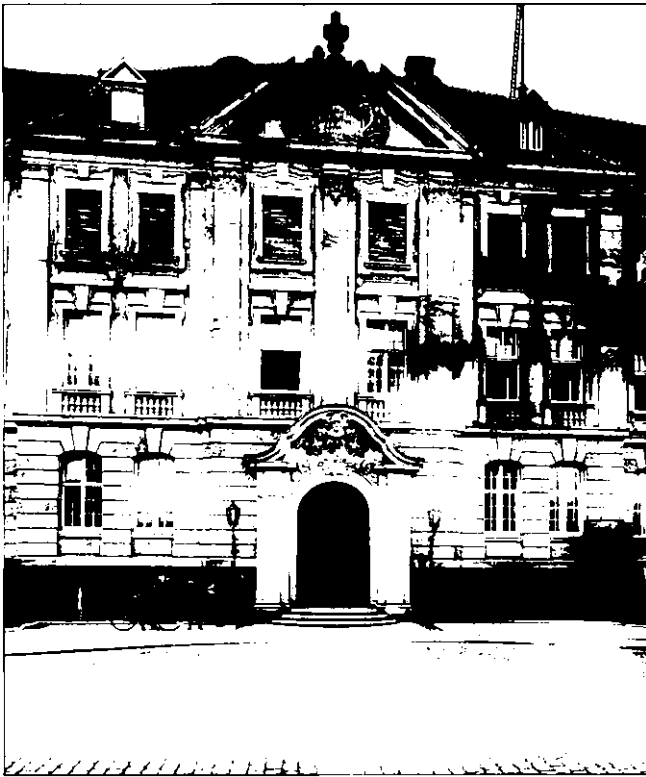
Abb. 132 Gerhart-Hauptmann-Strasse 16, Portalrisalit, Aufnahme vom 25. 6. 1914
