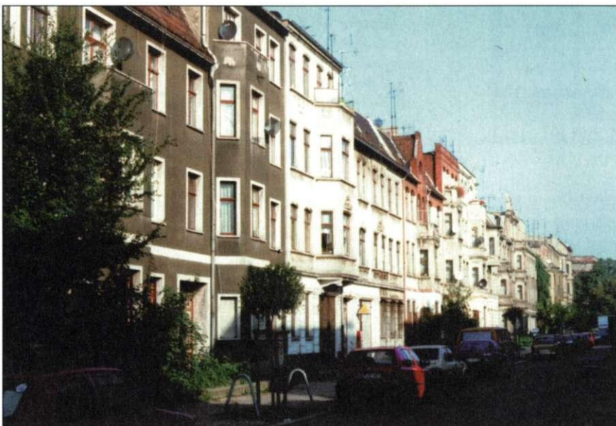
Abb. 96 Blick in die Friesenstraße nach Norden
