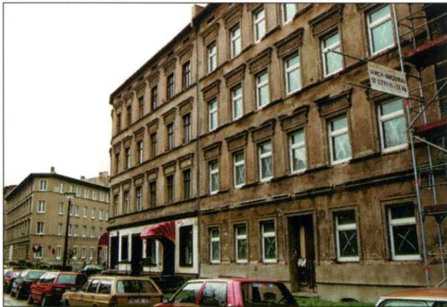
Abb. 60 Alexander-Puschkin-Straße 53 und 54, die Fenster sind mit auf Konsolen ruhenden Kragplatten versehen; im Mezzaningeschoß liegen schachtartige Öffnungen
