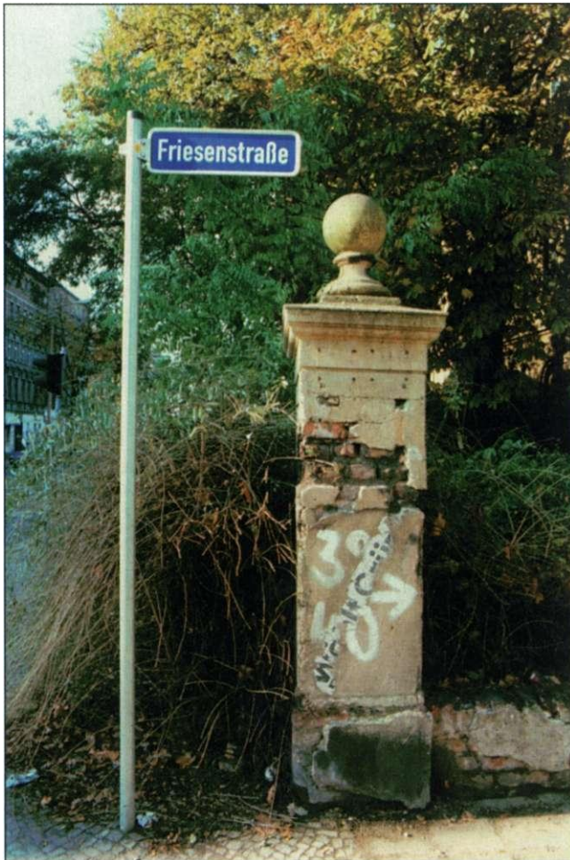
Abb. 324 Gemauerter Pfeiler, Olivenstedter Straße 39/40
