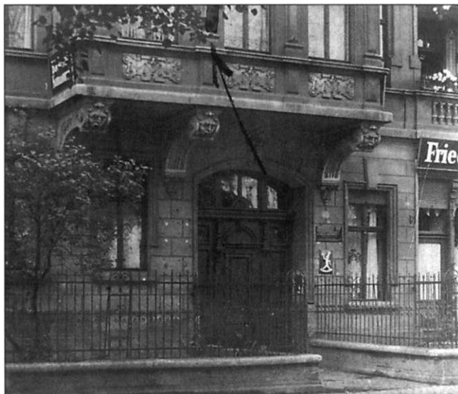
Abb. 303 Vorgarteneinfriedung Olvenstedter Straße 65, Foto spätestens 1929
